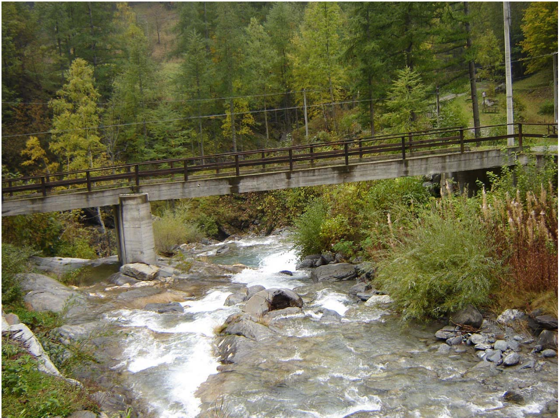
Foto 010 – Opera TREVPO005 . Ripresa da monte, sponda sinistra del T. Germanasca di Massello.
