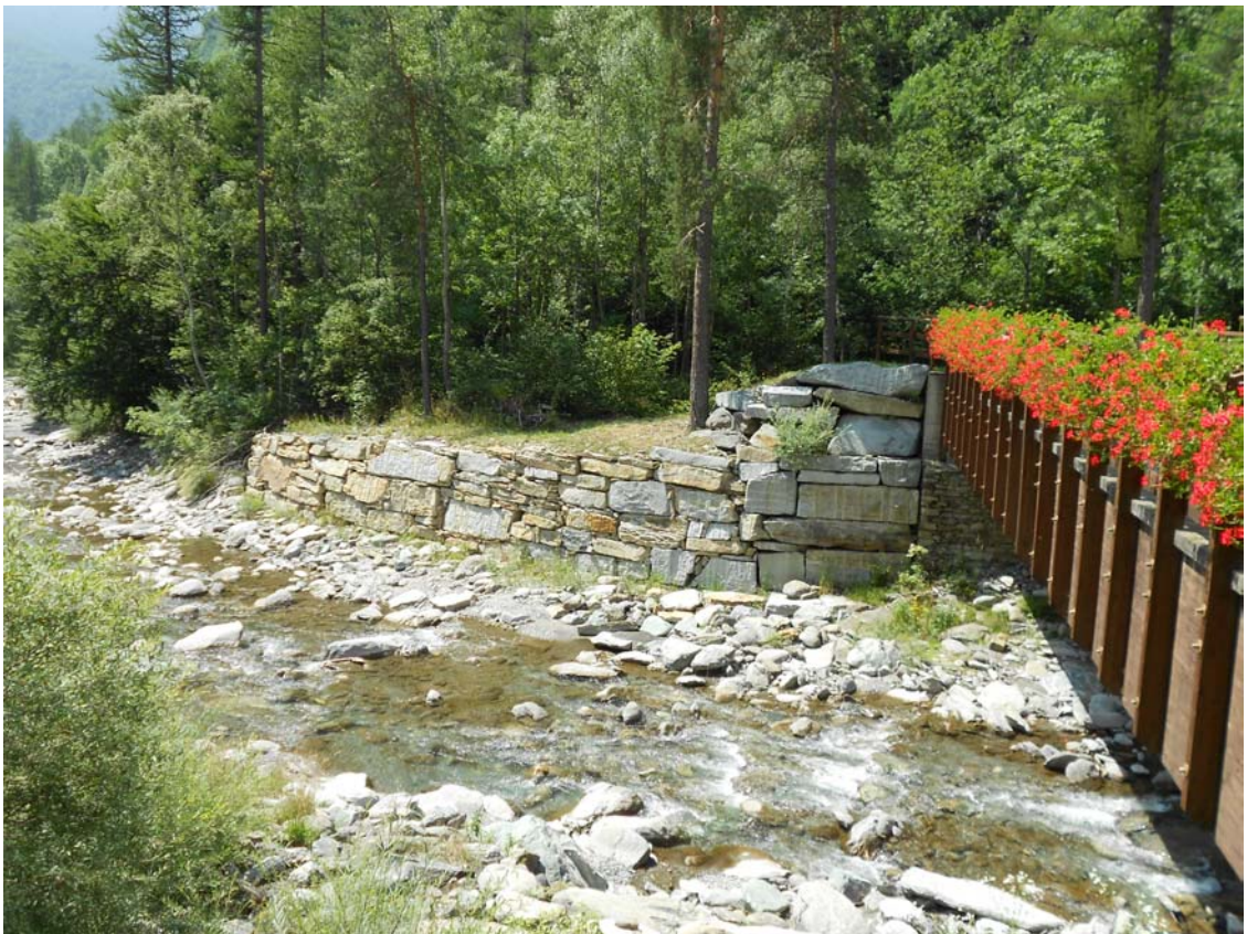
Foto 008 – Opera ZANEDS010 . Località Pro Loco – Ripresa dal ponte
