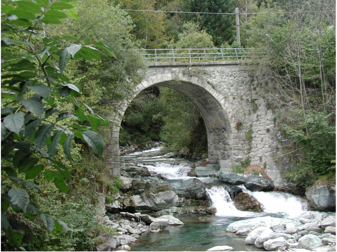
Foto 001 – Opera TREVPO001 . Foto scattata da valle verso monte, in sponda destra del T. Germanasca di Massello.
