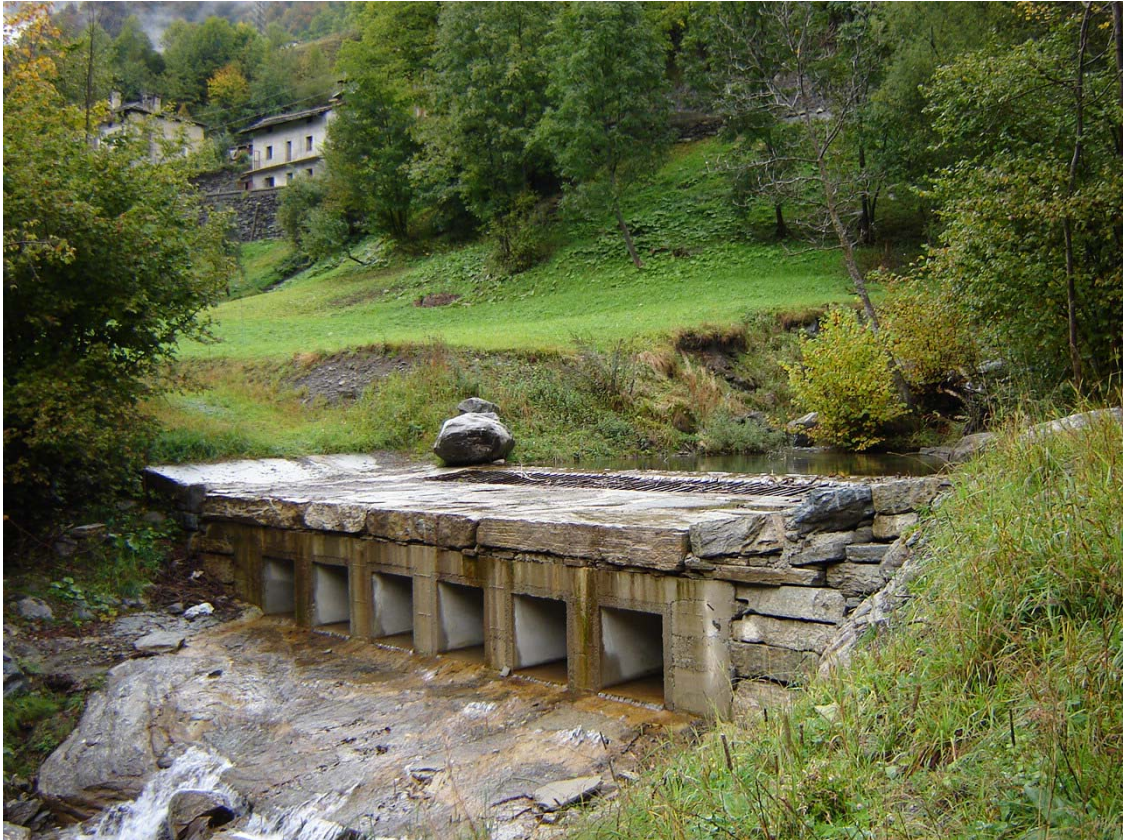
Foto 008 – Opera PENNAG010 . Ripresa da valle, sponda sinistra del T. Occie.
