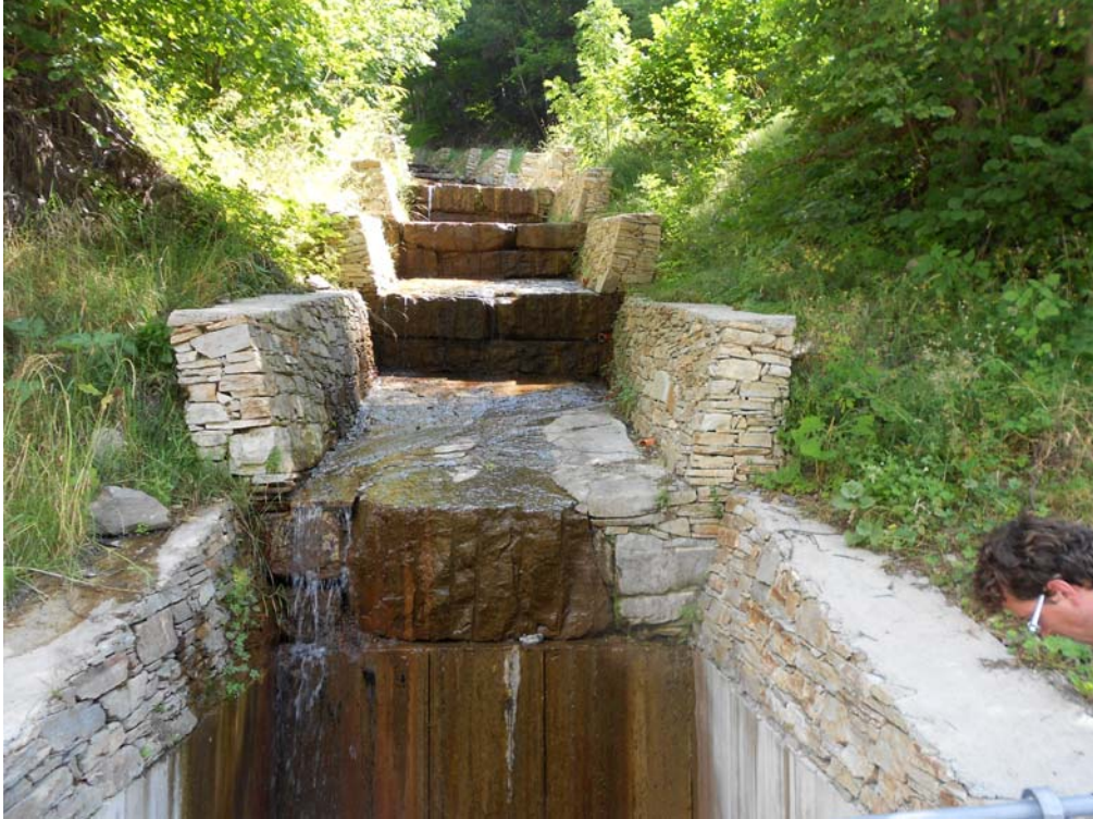
Foto 005 – Opera ZANECA004. Ripresa da valle.
