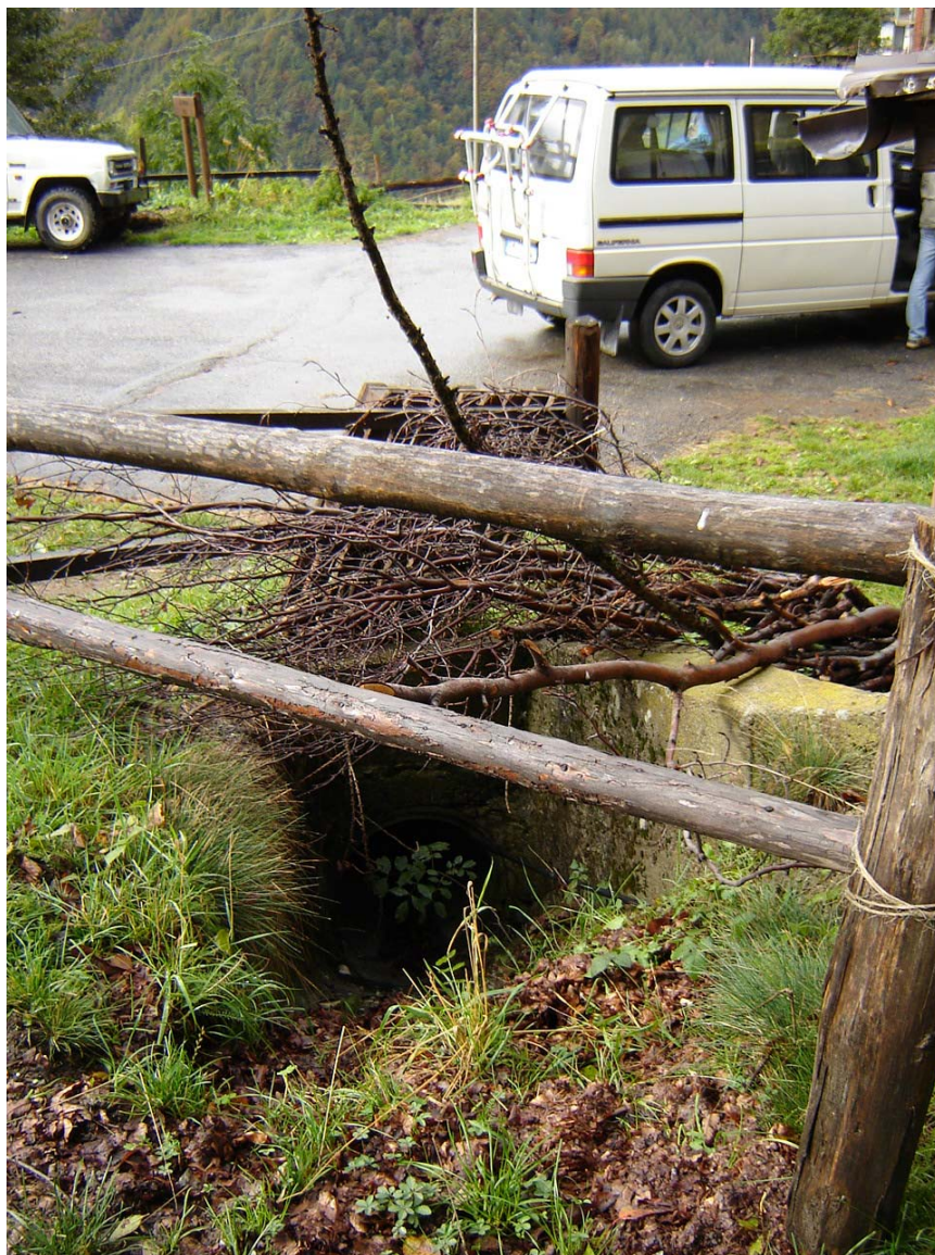
Foto 009 – Opera PENNAG011. Ripresa da monte, dall'alveo del Rio Porrence.
