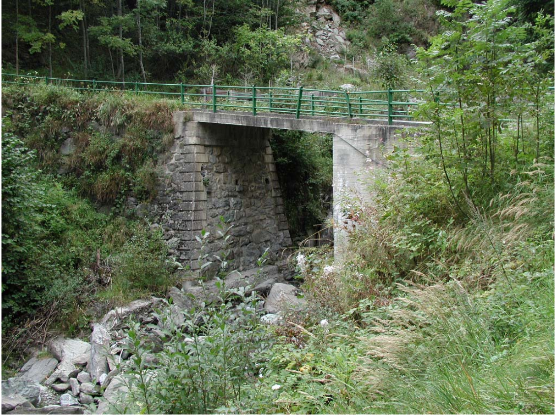
Foto 003 – Opera BATTAG005 . Foto scattata da valle verso monte, in sponda sinistra di un affluente del T. Germanasca di Massello.
