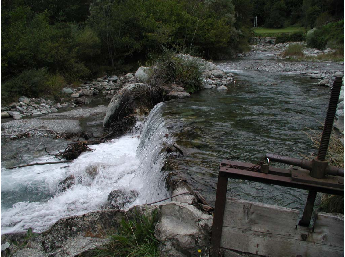
Foto 001 – Opera TREVS0001 . Foto scattata in corrispondenza dell'opera, in sponda sinistra idrografica del T. Germanasca di Massello.
