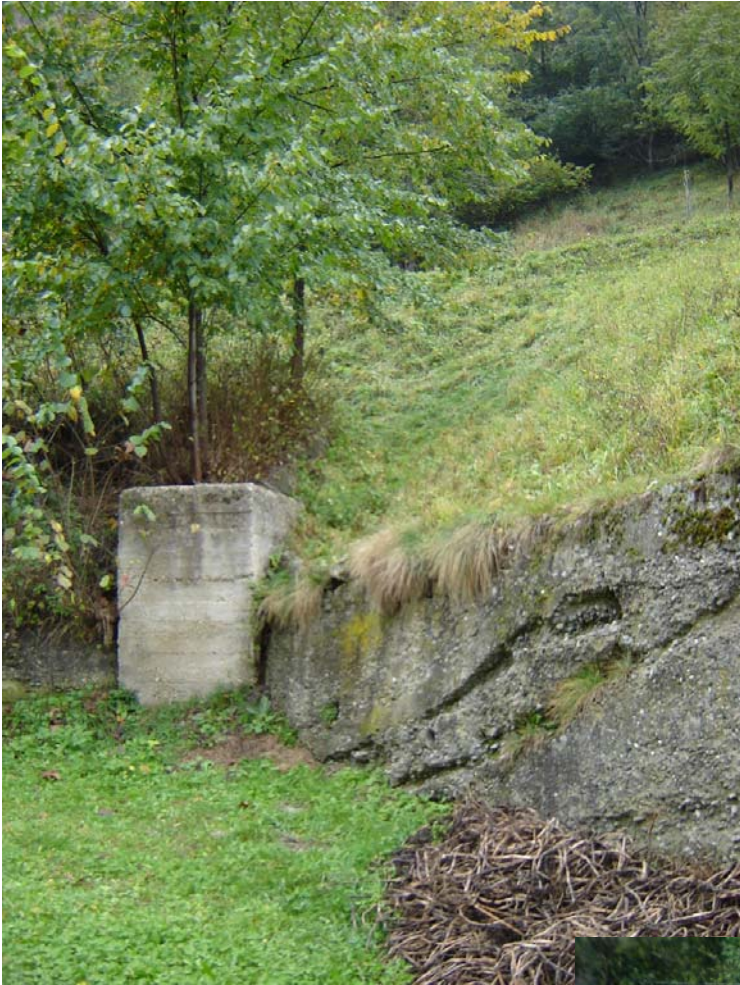
Foto 003 – Opera BATTCA003 . Ripresa da valle, parte centrale dell'opera.
