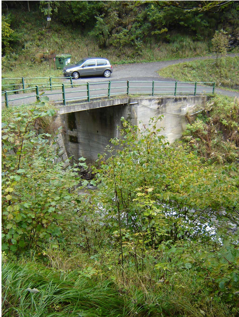
Foto 009 – Opera BATTPO004 . Ripresa da valle, sponda sinistra del Rio Rabbioso.
