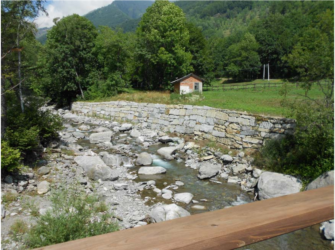
Foto 009 – Opera ZANEDS011 . Località Pro Loco – Ripresa dal ponte
