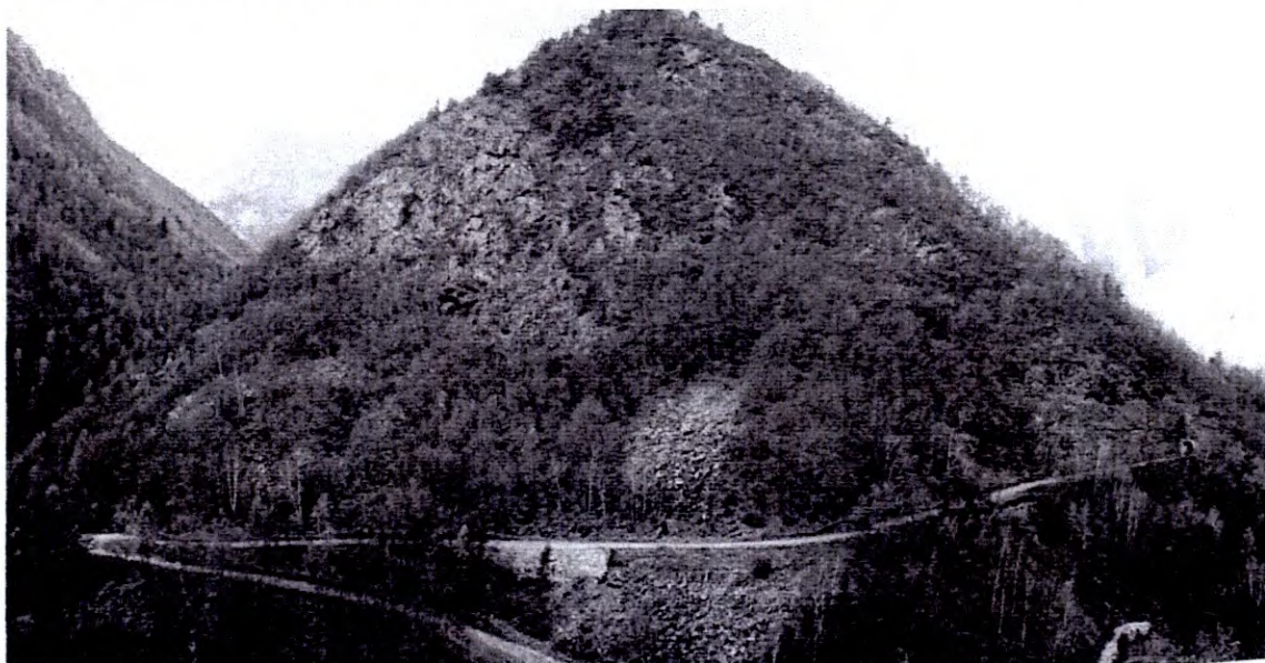
Comune di Perrero - Vista panoramica della parete che divide il vallone di Massello dalla Valle di Praly, prima che avvenisse il crollo del 16 marzo (foto 2007).
