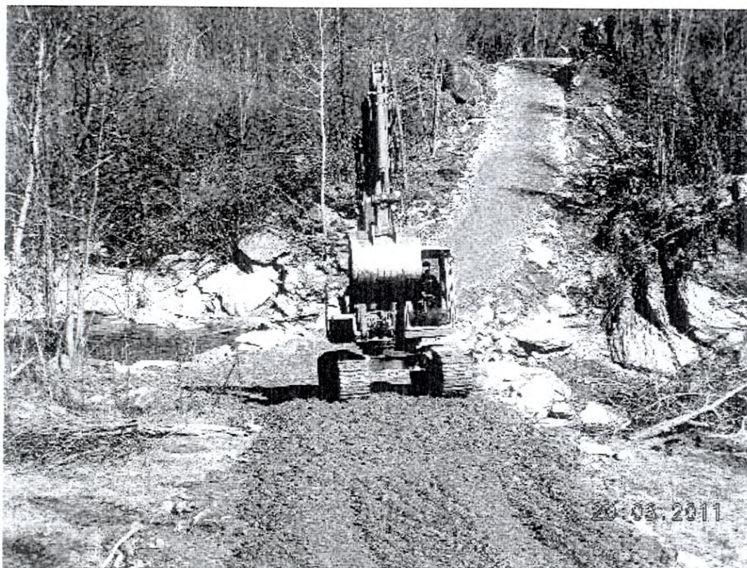
Fasi di costruzione del guado attraverso il Torrente Germanasca.
