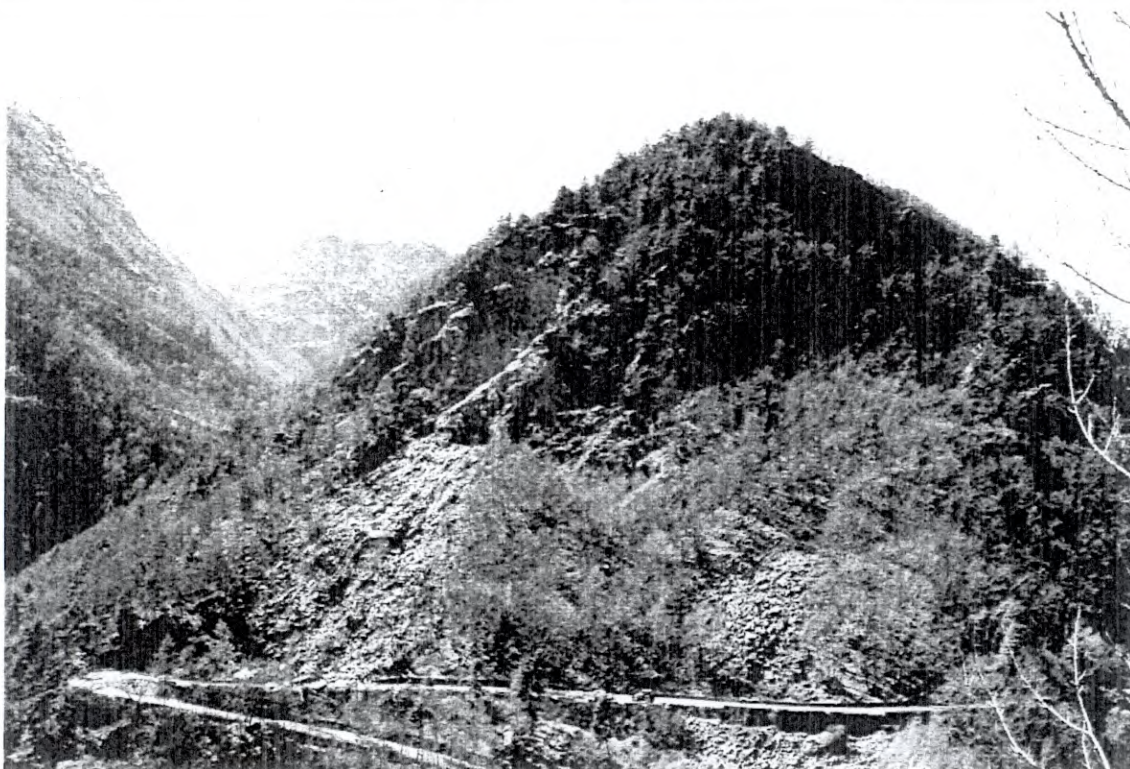
Comune di Perrero - Vista panoramica del crollo avvenuto alle ore 5:30 del giorno 16 marzo 2011.
