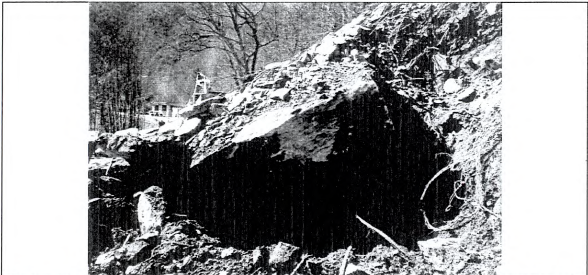
Comune di Perrero - crollo lungo la S.P. 169 in prossimità della loc. Airassa, sono presenti diversi blocchi di grandi dimensioni che impediscono la riapertura della strada. nella foto un blocco di circa 50 metri cubi all'interno dell'accumulo di frana.
