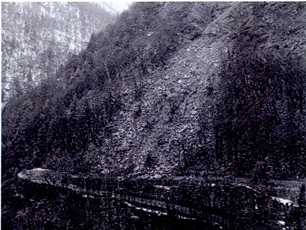
SP 170; fenomeno visto dal versante opposto.
