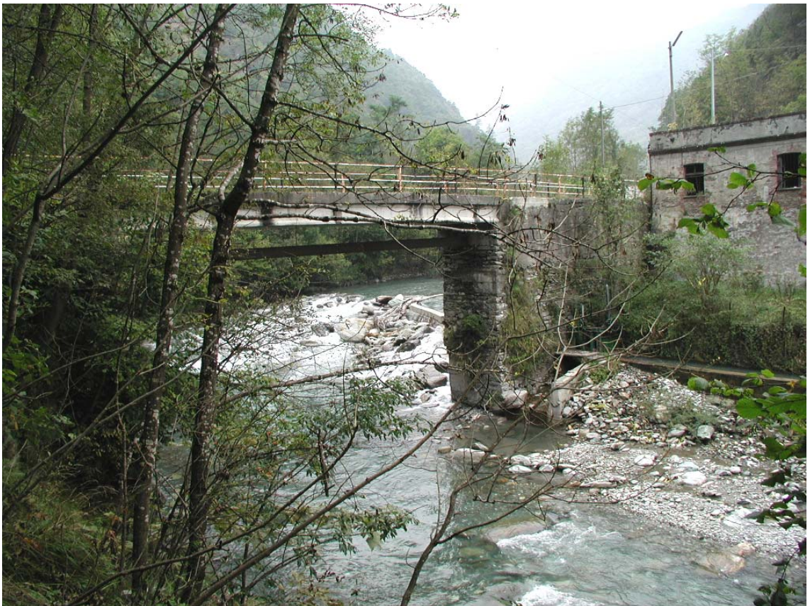
Foto 002 – Opera BATTPO002 . Foto scattata da valle verso monte, in sponda destra del T. Germanasca.
