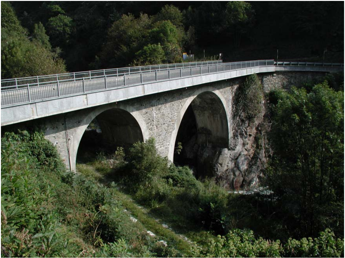
Foto 003 – Opera TREVPO003 . Foto scattata da valle verso monte, in sponda destra del T. Germanasca di Massello.
