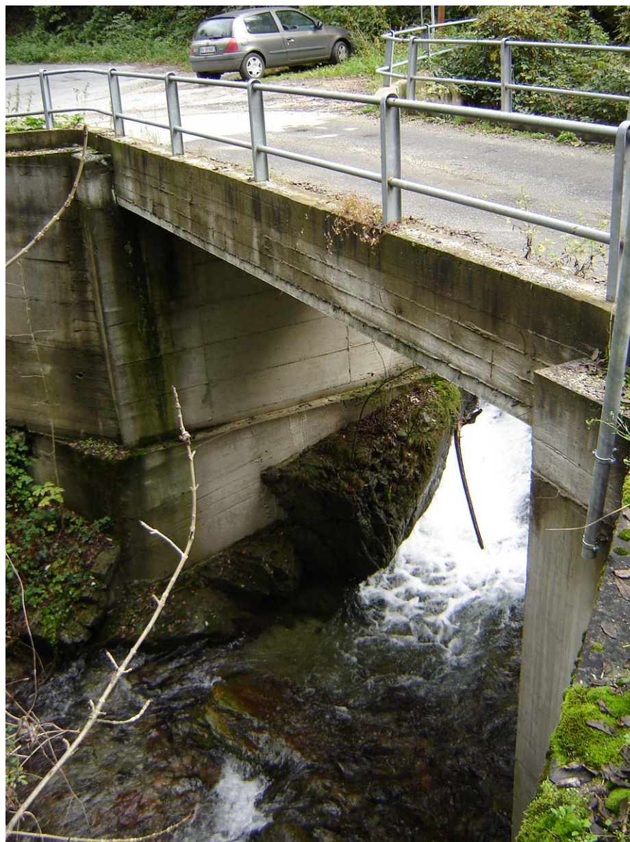
Foto 013 – Opera BATTPO013 . Ripresa da valle, sponda sinistra del rio affluente destro del T. Germanasca.
