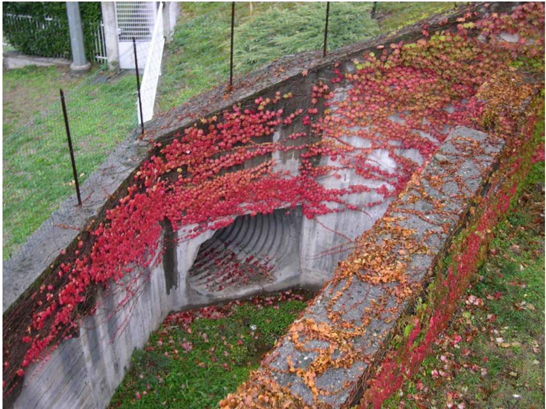
Foto 002 – Opera BELTCA002 . Ripresa da monte dell'opera.
