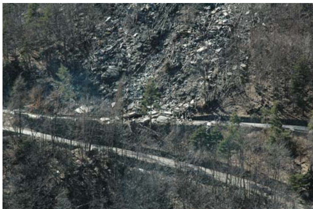
Comune di Perrero - A sinistra, Particolare della parte principale dell'accumulo di crollo che ha invaso la sede della S.P. 170. A destra tracce di impatto con danneggiamento della sede stradale in corrispondenza del Ponte Rabbioso.
