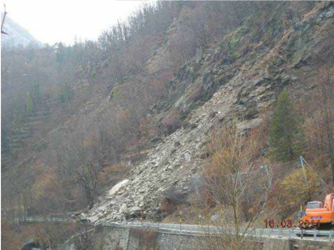
Località Ribbe, SP169. Fenomeno visto da valle.
