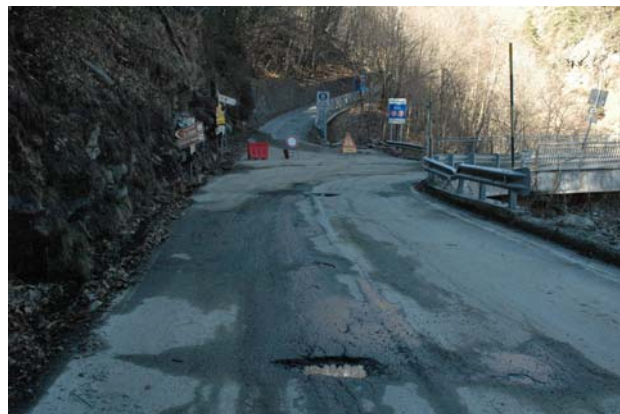
Comune di Perrero - A sinistra, Particolare della parte principale dell'accumulo di crollo che ha invaso la sede della S.P. 170. A destra tracce di impatto con danneggiamento della sede stradale in corrispondenza del Ponte Rabbioso.
