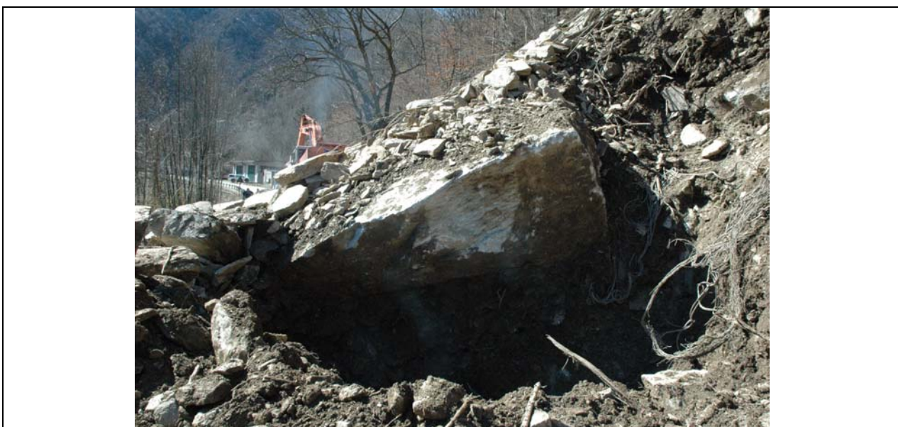
Comune di Perrero - crollo lungo la S.P. 169 in prossimità della loc. Airassa, sono presenti diversi blocchi di grandi dimensioni che impediscono la riapertura della strada. nella foto un blocco di circa 50 metri cubi all'interno dell'accumulo di frana.
