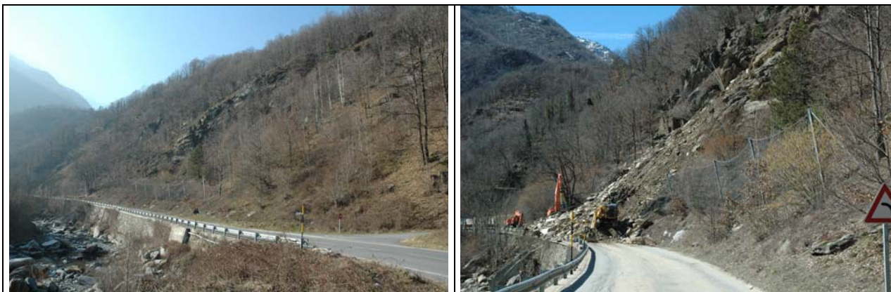
Comune di Perrero - zona da cui si è distaccato il crollo lungo la S.P. 169 in prossimità della loc. Airassa; a sinistra la zona prima del crollo (foto 2007); a destra la stessa zona dopo il crollo, parte dell'accumulo è già stato rimosso (foto del 18 marzo 2011).
