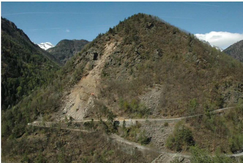
Immagine 03 - Vista frontale del crollo. Foto del 13.04.2011
