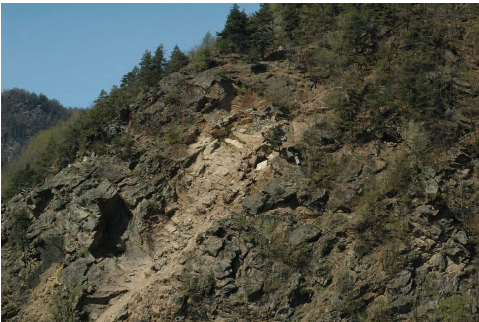
Immagine 02 - Dettaglio della zona di distacco del crollo. Foto del 13.04.2011
