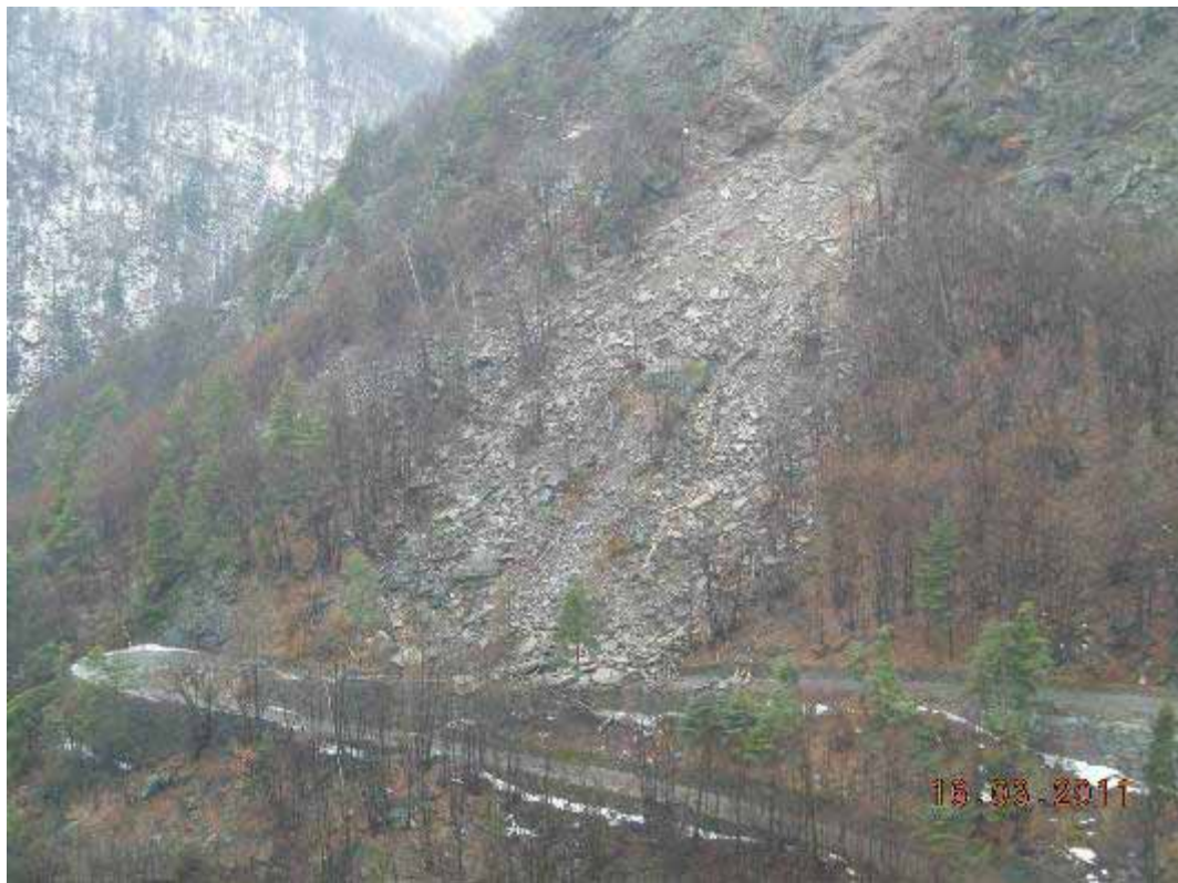
SP 170; fenomeno visto dal versante opposto.
