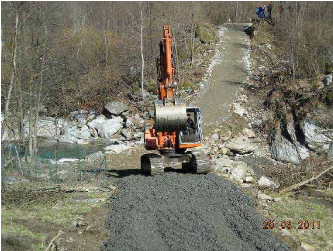
Fasi di costruzione del guado attraverso il Torrente Germanasca.
