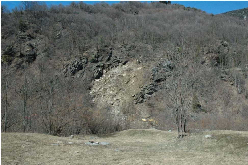
Immagine 01 - Vista frontale del crollo. Foto del 13.04.2011
