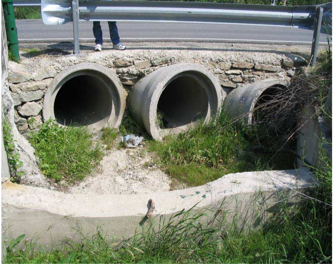
Foto 010 – Opera BATTAG011 . Ripresa da monte, all'interno del rio relativo, affluente di destra del T. Germanasca.
