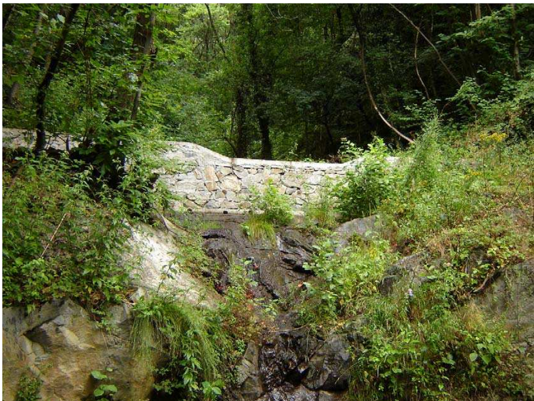
Foto 004 – Opera BATTBR004 . Ripresa da valle, dall'attraversamento BATTAG003 .
