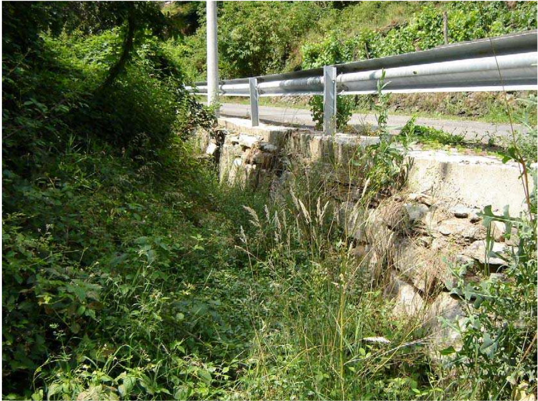
Foto 007 – Opera BATTDS007 . Ripresa da valle, dall'attraversamento BATTAG015.
