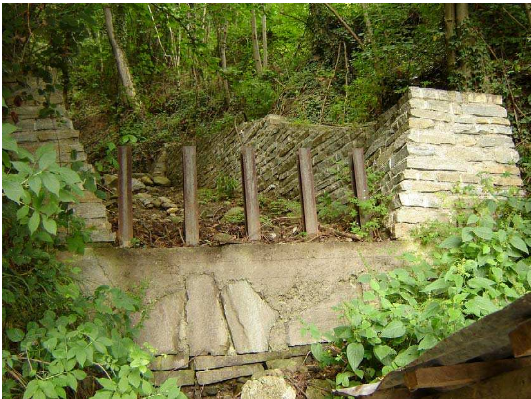
Foto 001 – Opera BATTBR001 . Ripresa da valle, sponda sinistra del Rio di Pons.
