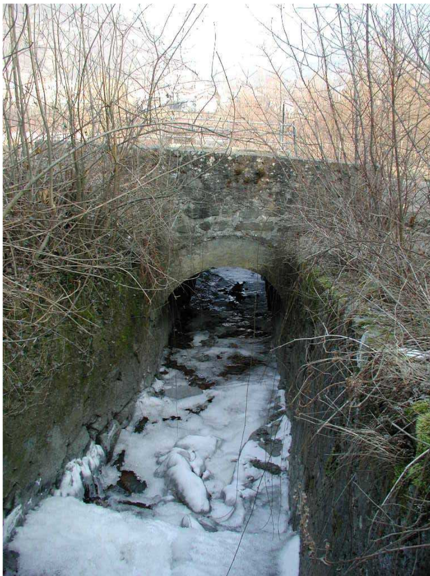
Foto 005 – Opera BATTAG006 . Ripresa da monte, in corrispondenza dell'attraversamento BATTAG007 .
