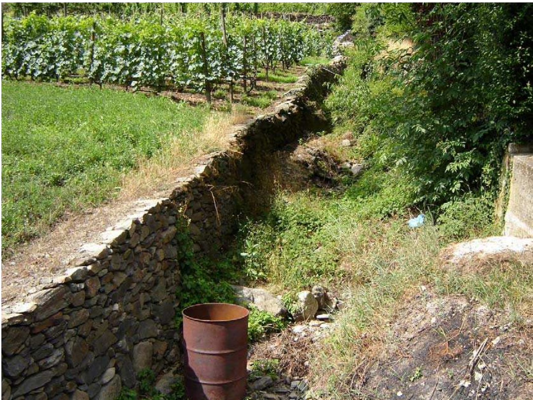
Foto 008 – Opera BATTDS008 . Ripresa da valle, sponda destra del Rio di Blegieri.
