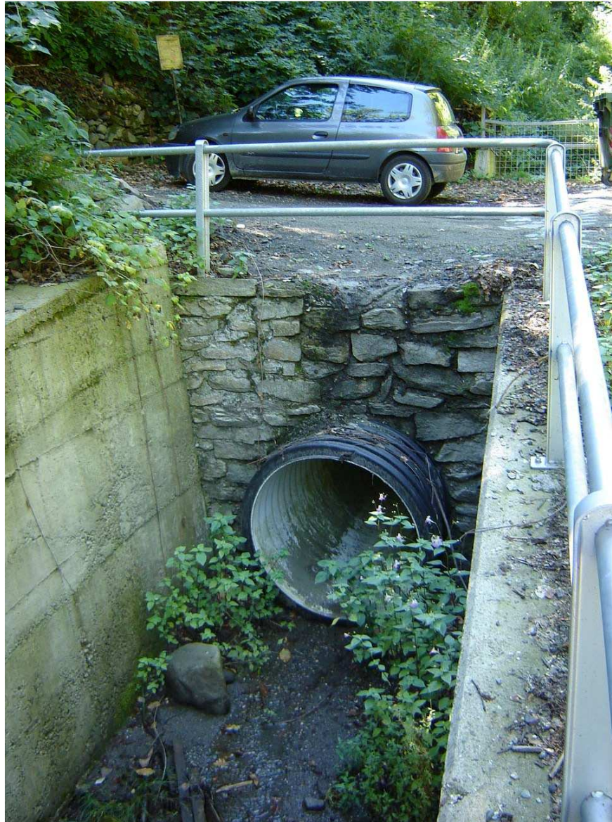
Foto 016 – Opera BATTAG017 . Ripresa da valle, sponda sinistra del rio Clot di Boulard.
