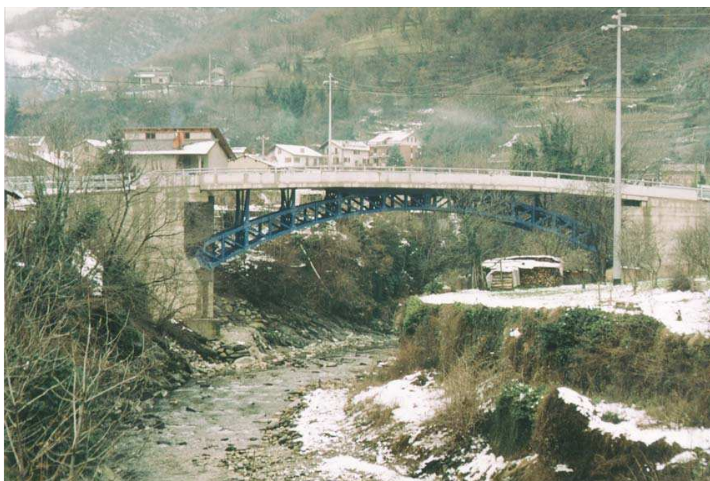
Foto 002 – Opera BATTPO002 . Ripresa da valle, in corrispondenza del ponte TREVPO001 , sul T. Germanasca.
