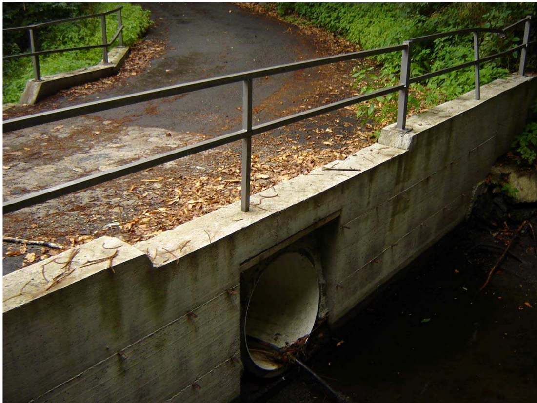
Foto 003 – Opera BATTAG003 . Ripresa da monte, sponda sinistra del Rio Blegieri.
