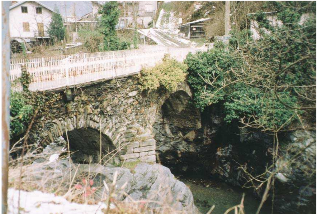
Foto 003 – Opera TREVPO003 . Ripresa da monte, sponda sinistra del T. Germanasca.
