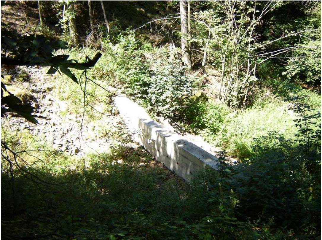
Foto 006 – Opera BATTBR006 . Ripresa da monte, sponda destra del rio Clot di Foulard.
