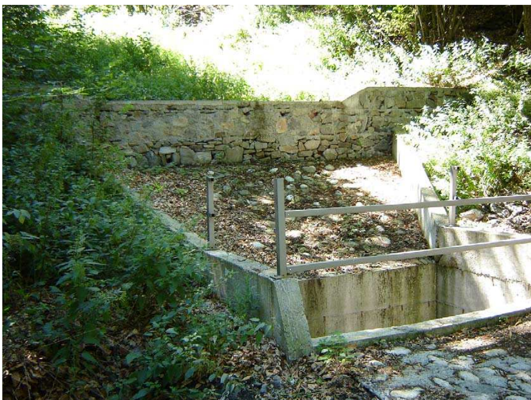
Foto 005 – Opera BATTBR005 . Ripresa da valle, dall'attraversamento TREVAG004 .
