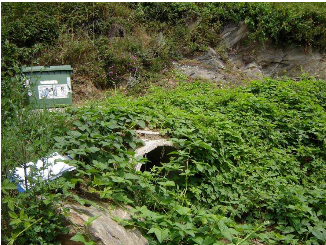
Foto 012 – Opera BATTAG013 . Ripresa da valle sul Rio del Podio.
