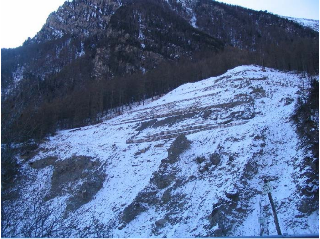
Foto 001 – Opera PENNOSS001. Ripresa frontale dalla SS 23.
