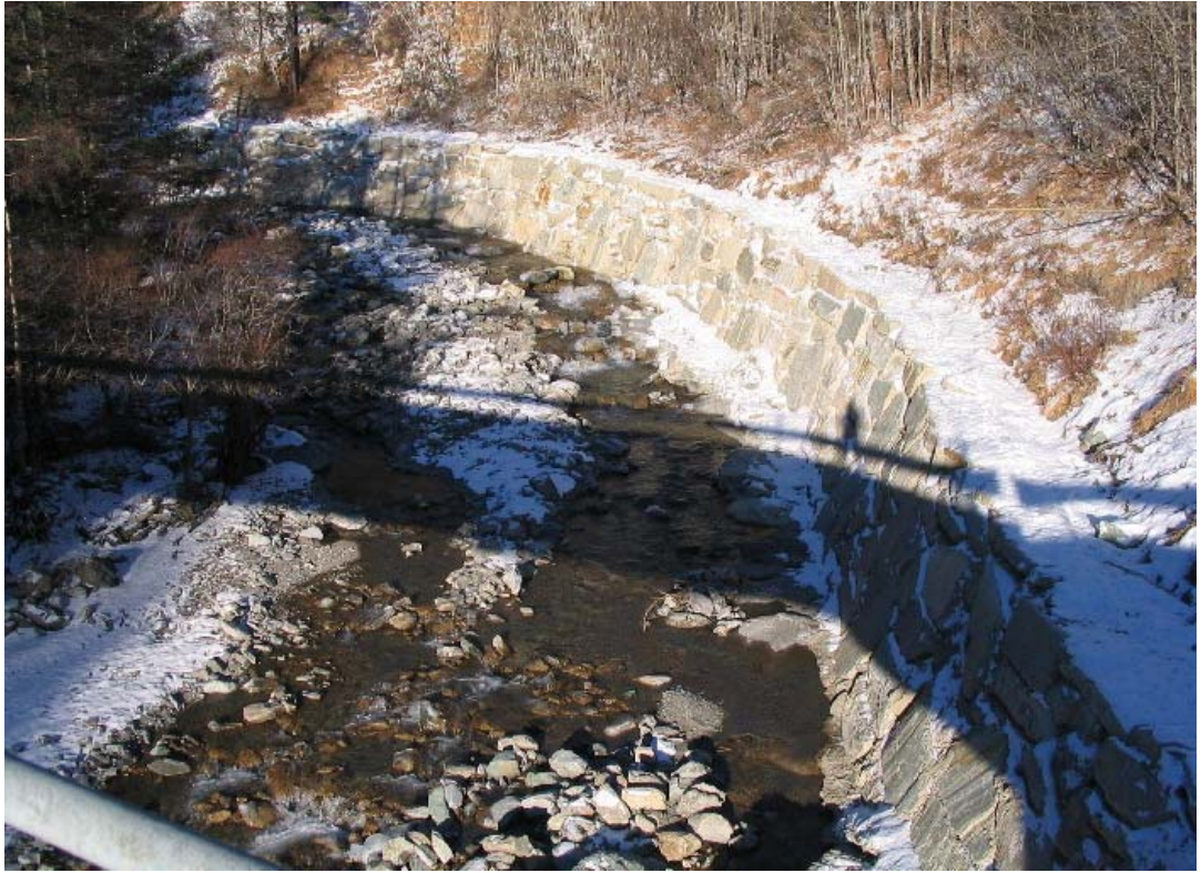
Foto 011 – Opera BATTDS012 . Ripresa da valle, dal ponte BATTPO001.
