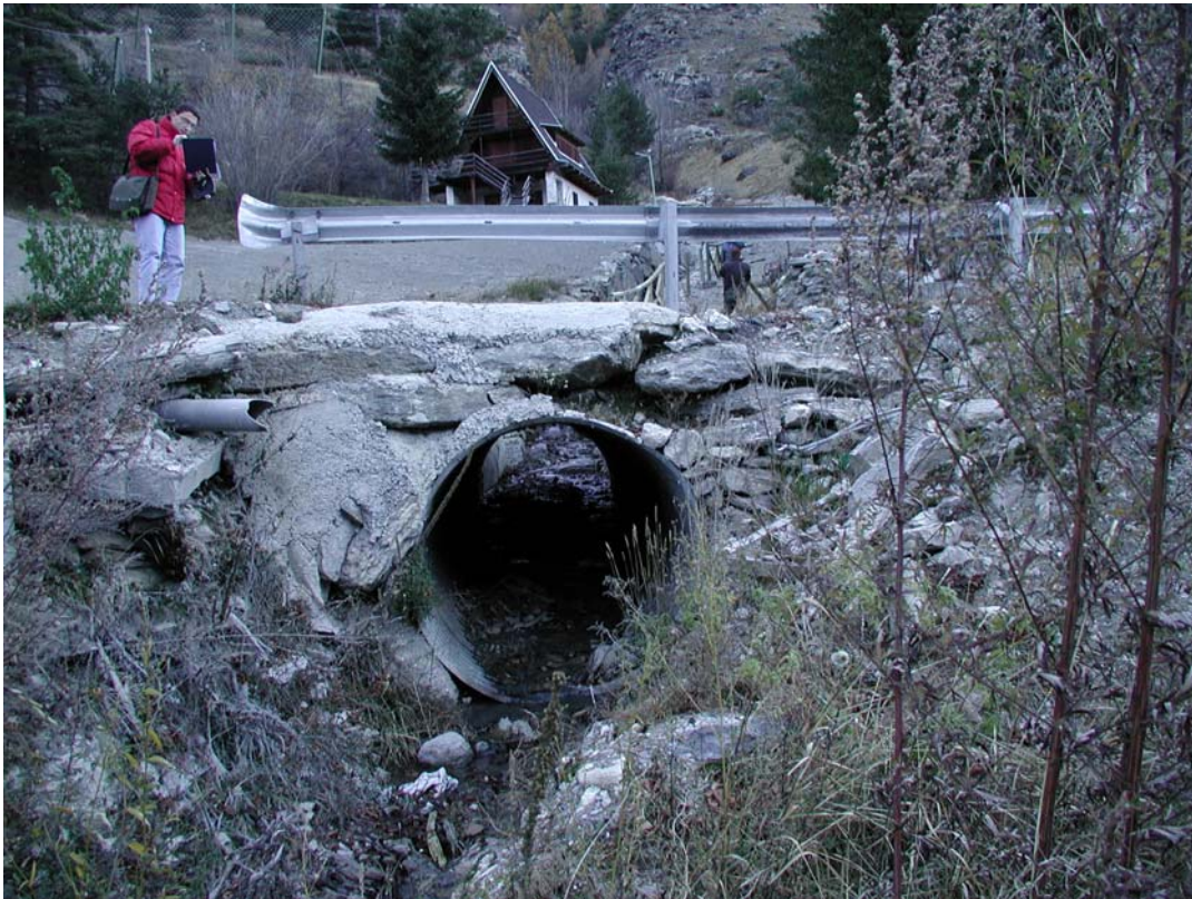
Foto 001 – Opera BATTAG001 . Ripresa da valle, sponda destra del rio.
