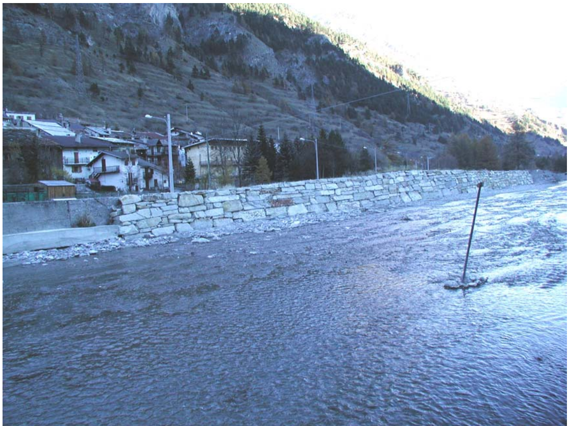
Foto 002 – Opera BELTDS002 . Da monte, sponda destra del T. Chisone.
