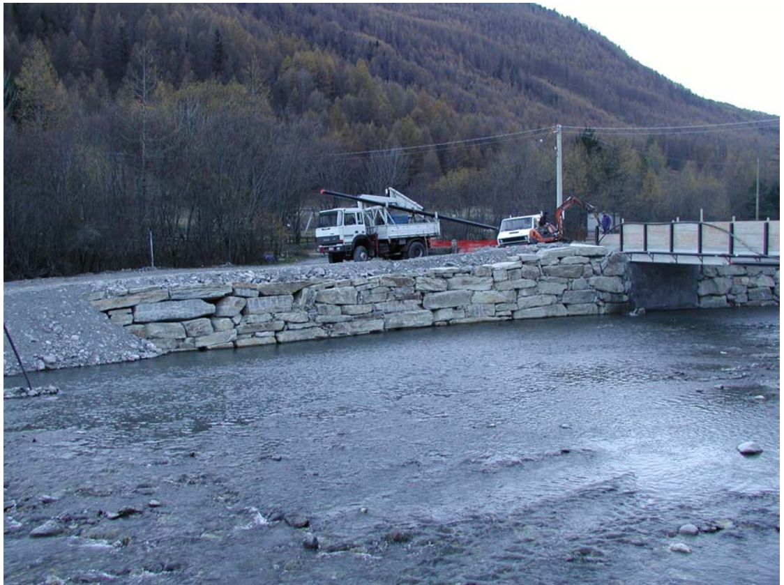
Foto 001 – Opera BATTDS001 . Di fronte, da sponda sinistra del T. Chisone.
