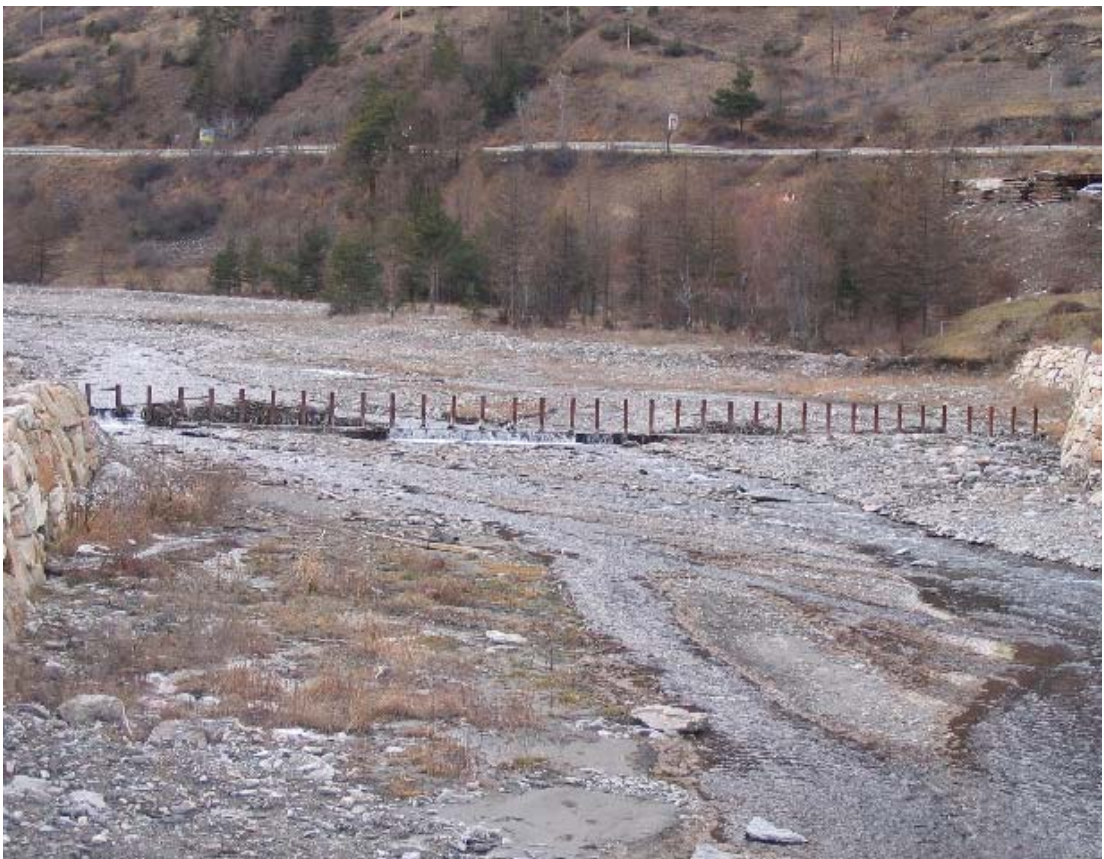
Foto 004 – Opera BATTSO005 . Ripresa da valle, dal ponte BELTPO002.
