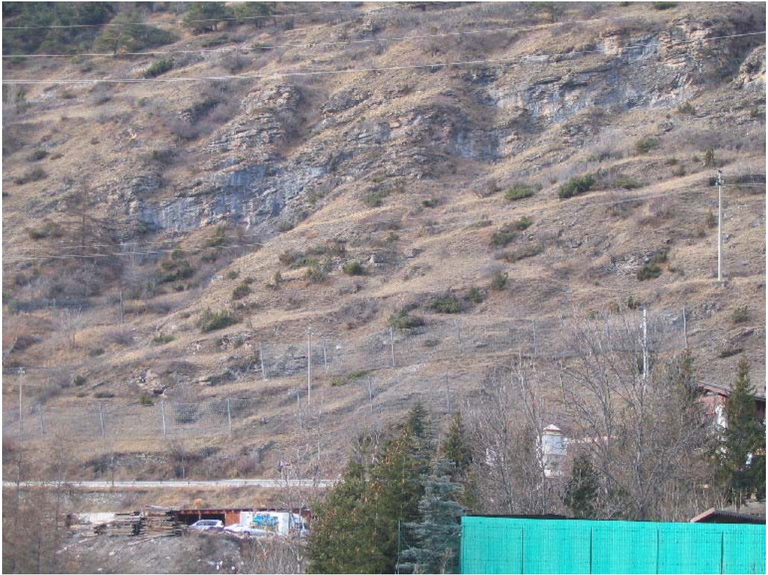
Foto 001 – Opera BATTPR001 . Ripresa da valle dal ponte BELTPO002.
