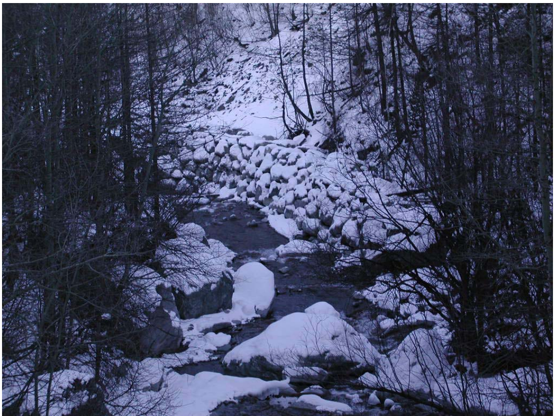
Foto 012 – Opera BATTDS013 . Ripresa da monte, dal ponte BATTPO001.
