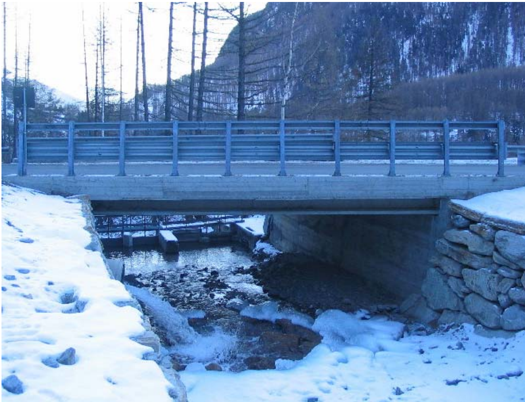
Foto 007 – Opera PENNPO007. Ripresa da monte, sponda sinistra del R. Assietta.
