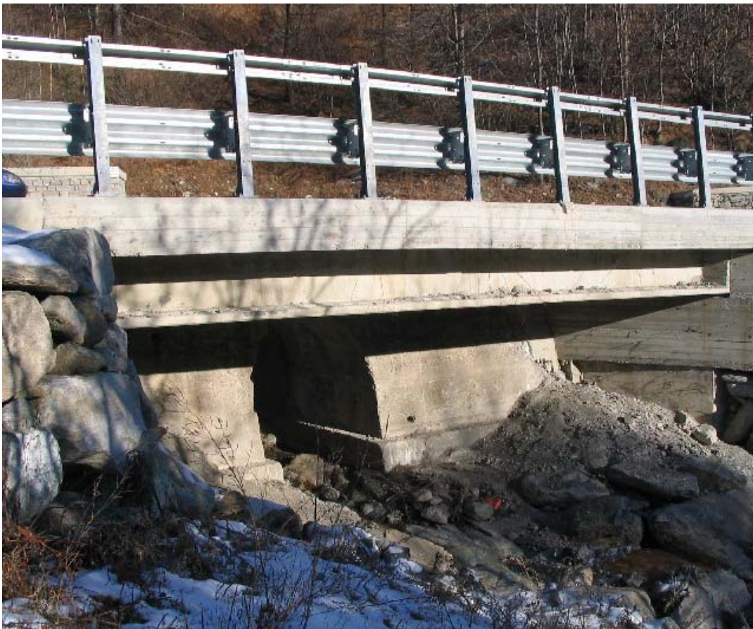
Foto 004 – Opera PENNAG004 . Ripresa da valle, sponda destra del rio.
