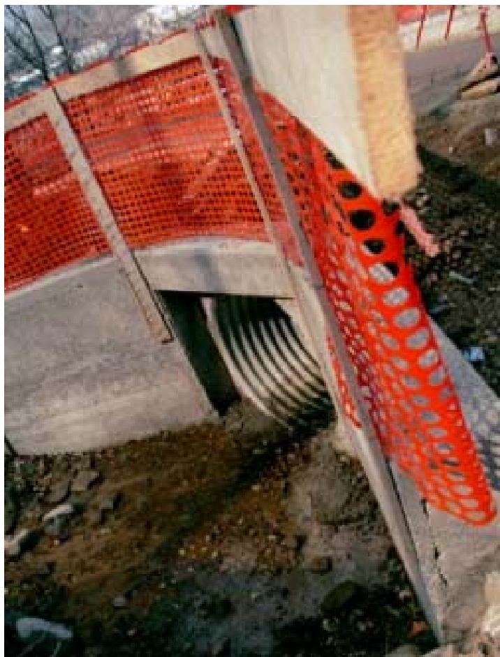
Foto 027 – Opera CANAAG027 . Ripresa da monte.
