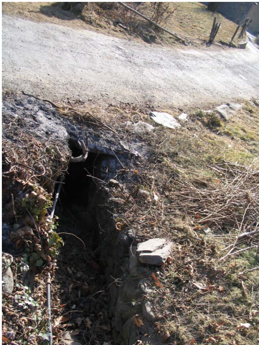
Foto 005 – Opera BATTCA005 . Ripresa dall'imbocco di monte.
