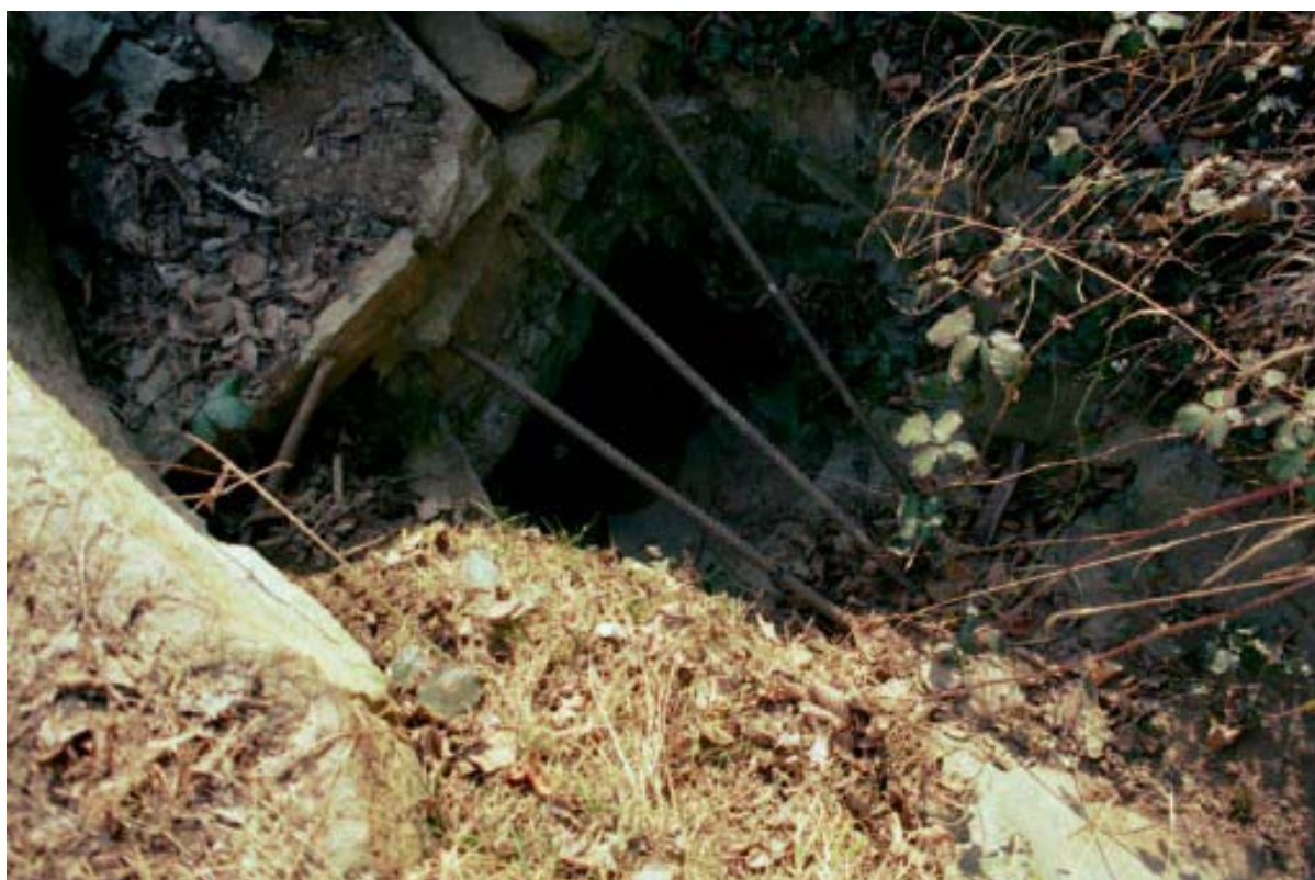
Foto 016 – Opera TREVAG016 . Ripresa dall'alto da monte.
