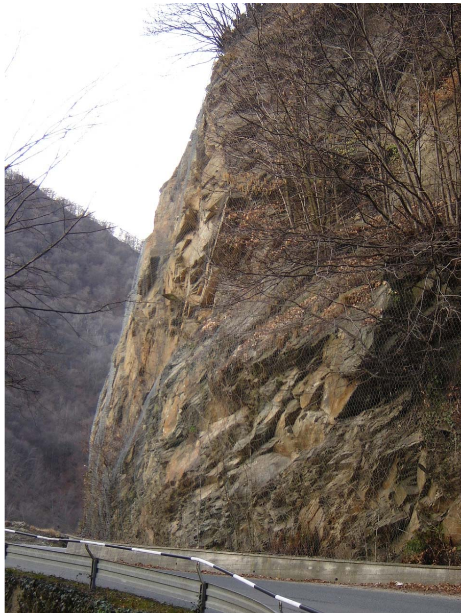
Foto 001 – Opera BATTPR001 (paramassi) – Ripresa da valle.
