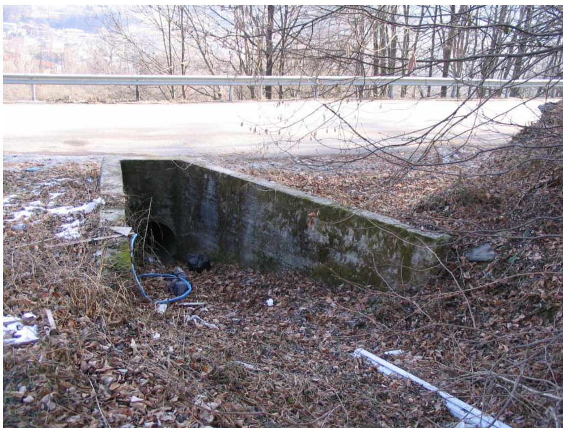
Foto 006 – Opera TREVAG006 . Ripresa da monte.
