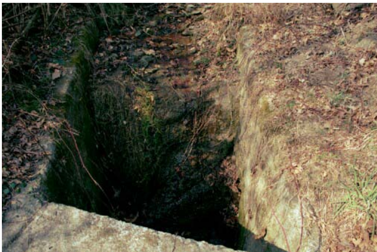
Foto 001 – Opera CANASO001 . Ripresa da valle, dall'attraversamento CANAAG017.
