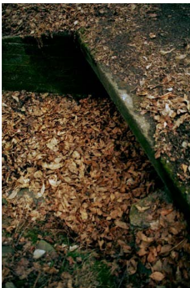
Foto 038 – Opera TREVAG038 . Ripresa dall'alto da valle
