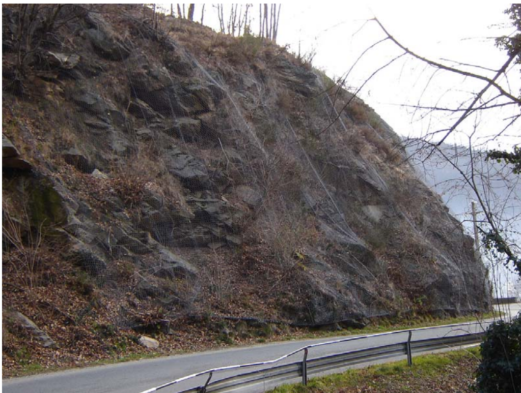
Foto 002 – Opera PENNPR002 (paramassi) – Ripresa da monte.
