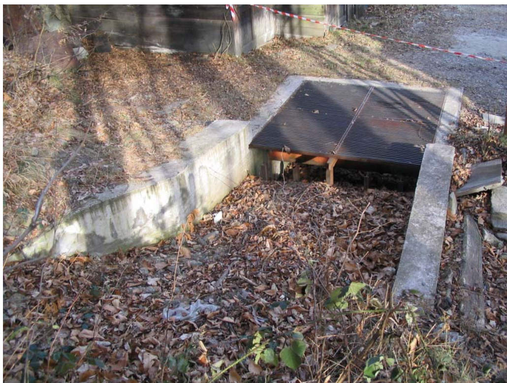
Foto 004 – Opera PENNCA004 . Ripresa dall'imbocco di monte.
