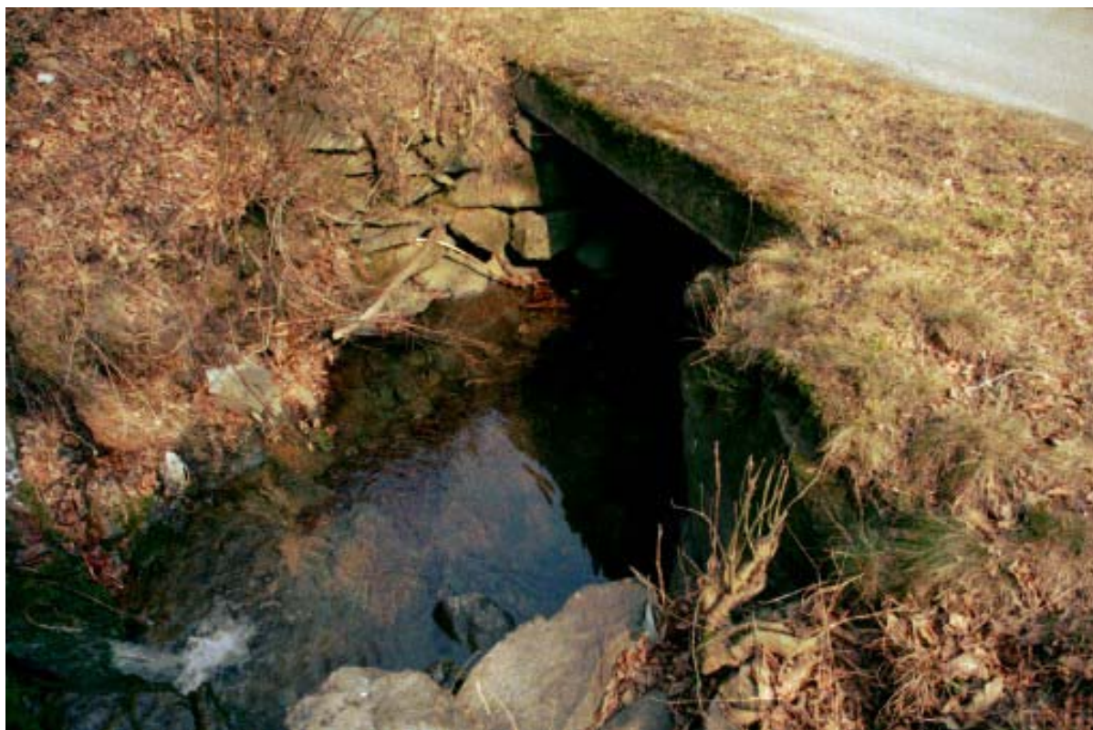
Foto 029 – Opera CANAAG029 . Ripresa da monte.
