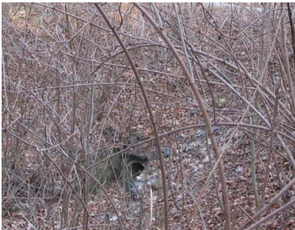
Foto 013 – Opera CANAAG013 . Ripresa da monte.
