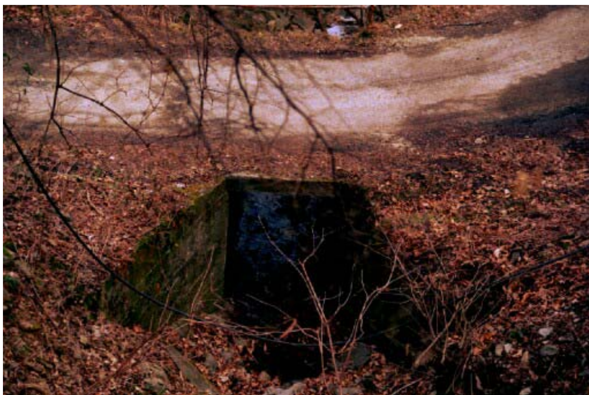
Foto 036 – Opera TREVAG036 . Ripresa da monte.
