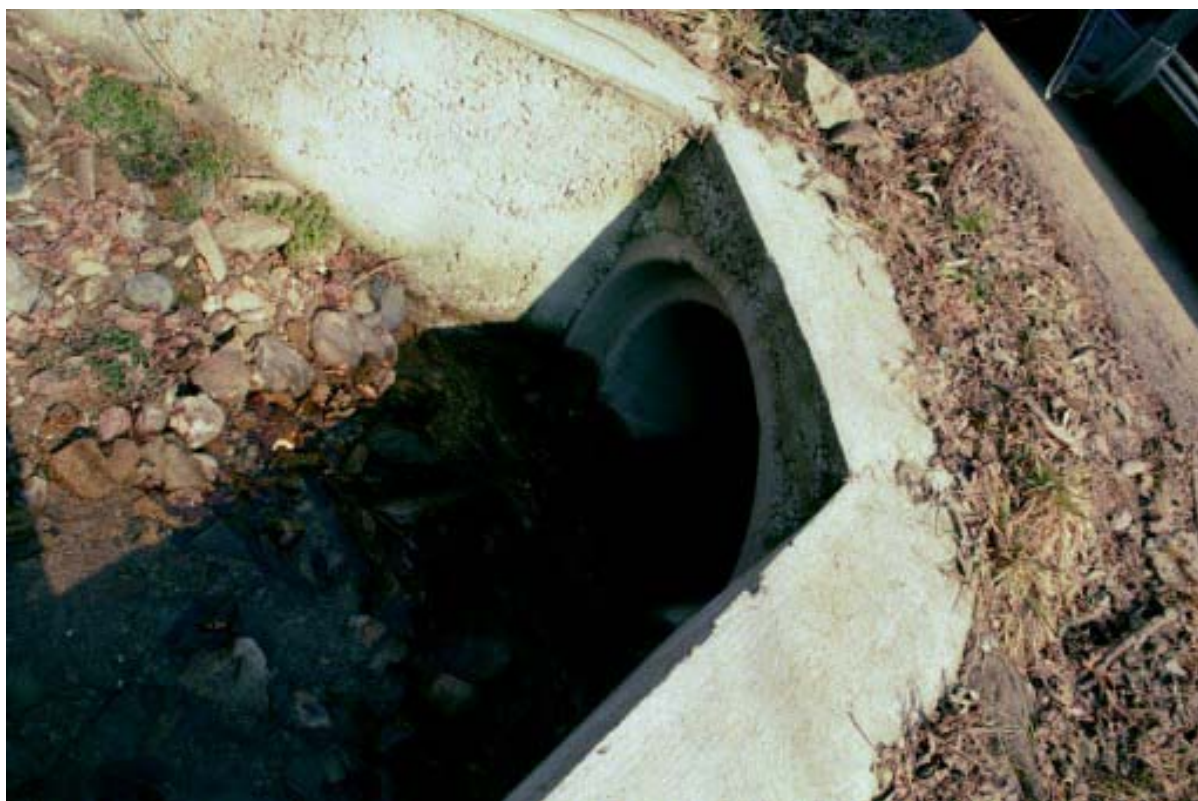
Foto 021 – Opera CANAAG021 . Ripresa da monte.
