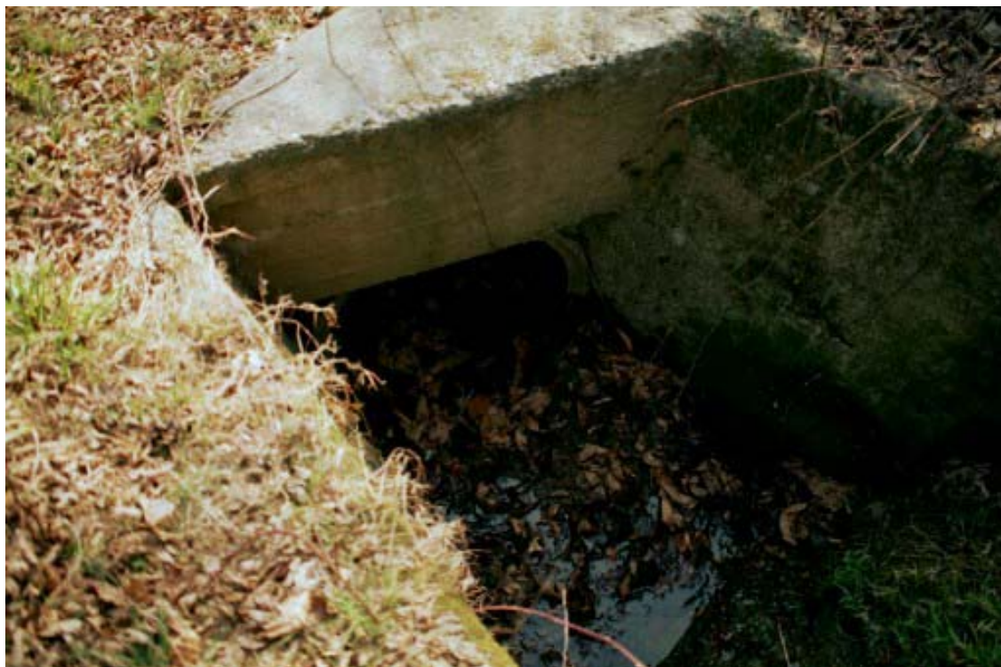
Foto 017 – Opera CANAAG017 . Ripresa da monte.
