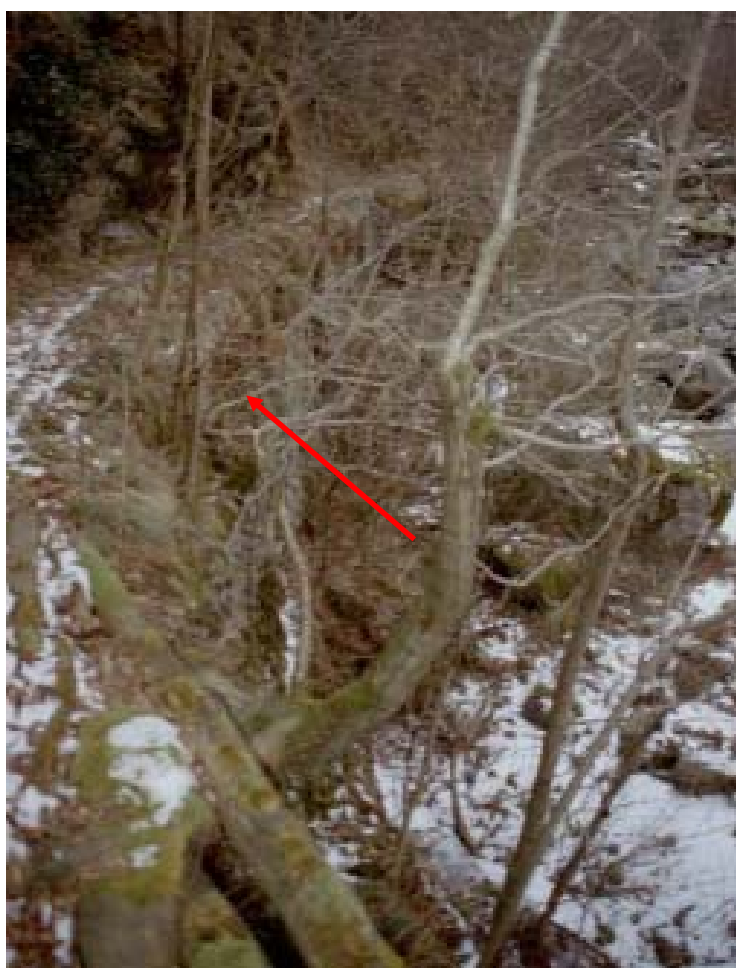
Foto 012 – Opera TREVDS012 . Ripresa da valle, sponda destra del T. Risagliardo.
