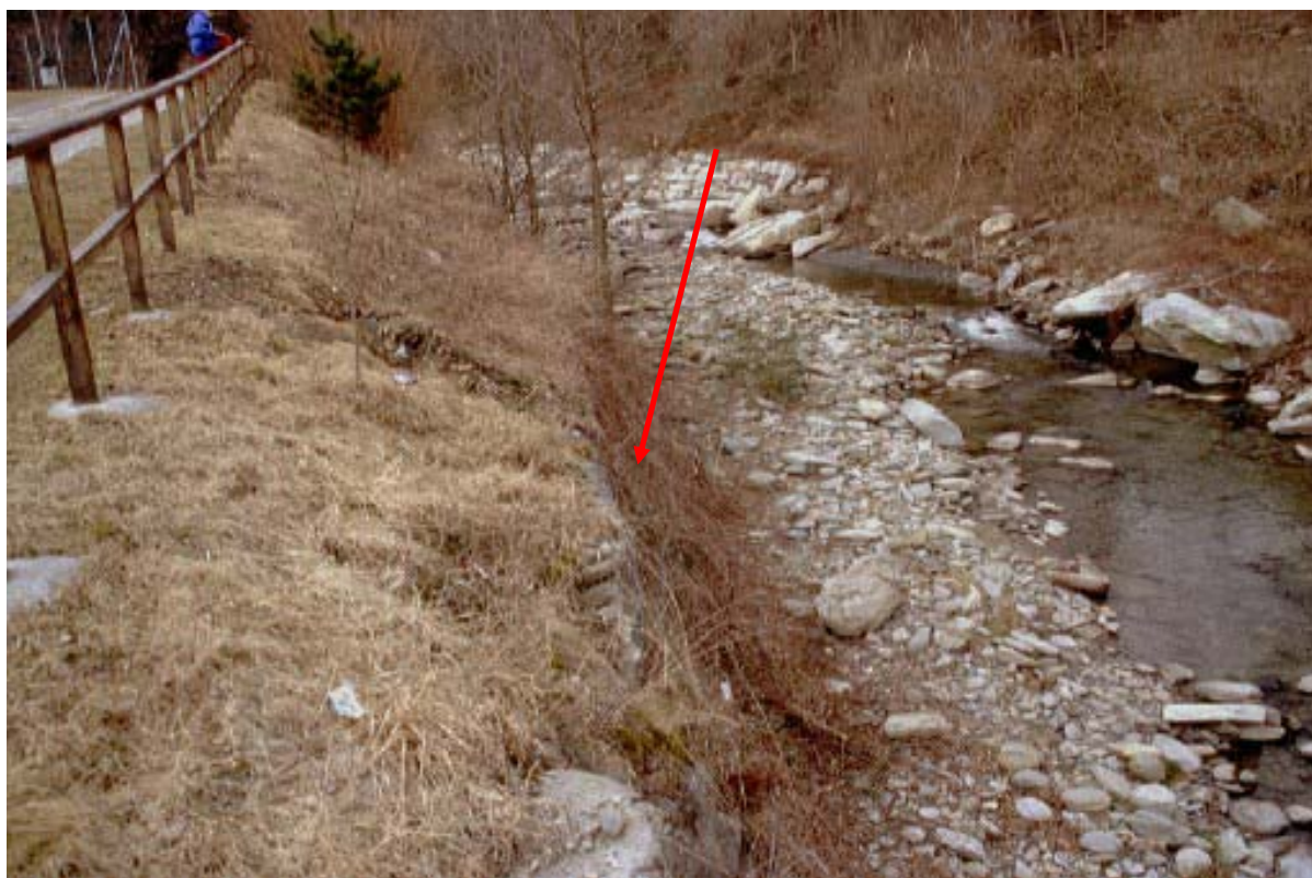
Foto 010 – Opera TREVDS010 . Ripresa da valle, sponda destra del T. Risagliardo.
