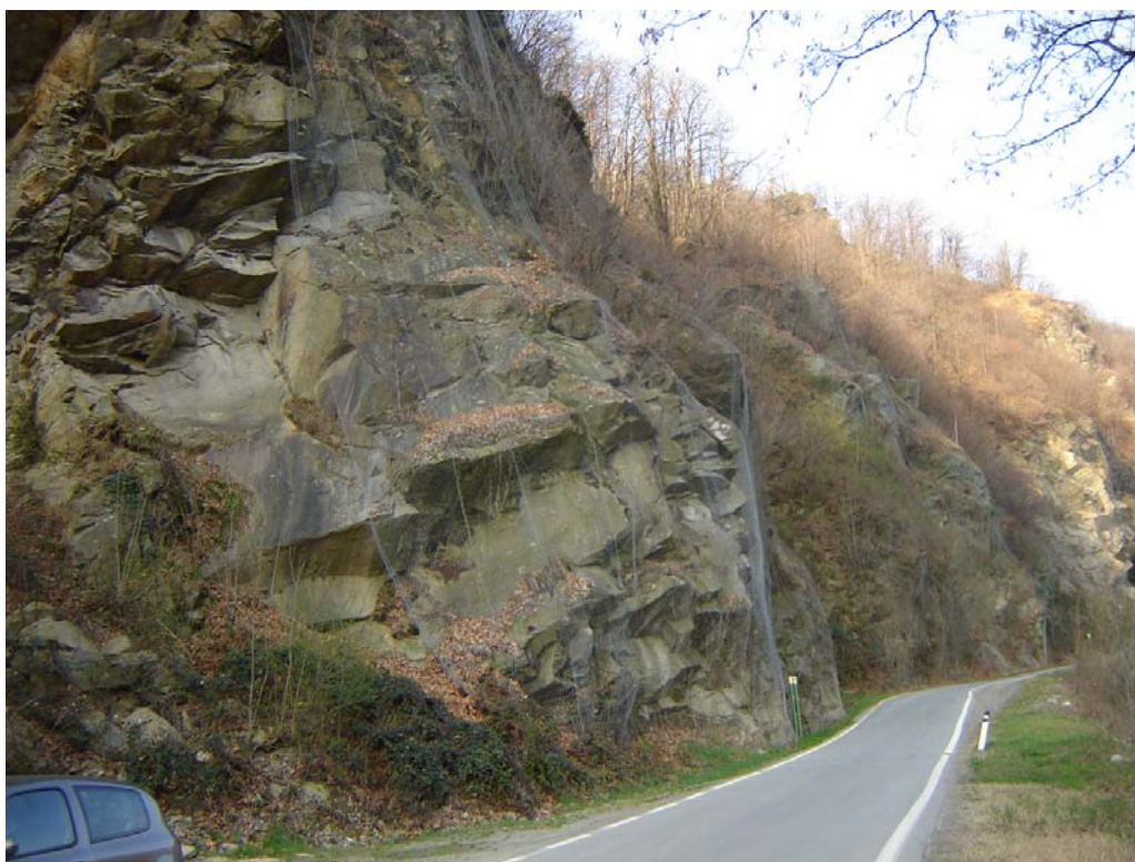
Foto 003 – Opera BATTPR002 (paramassi) – Ripresa da valle.
