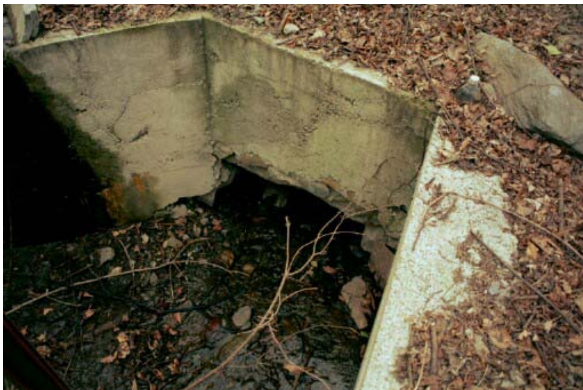
Foto 010 – Opera TREVAG010 . Ripresa da monte.
