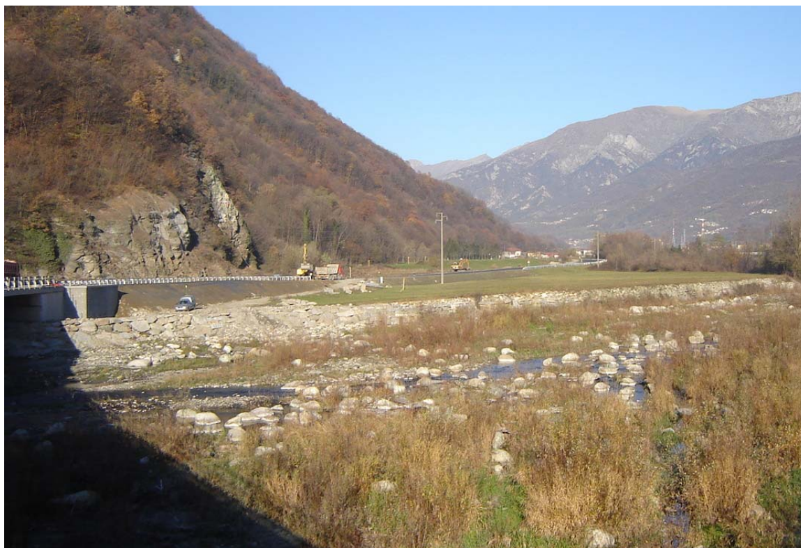
Foto 019 – Opera BATTDS019 . Ripresa frontale dal ponte sul T. Chisone.
