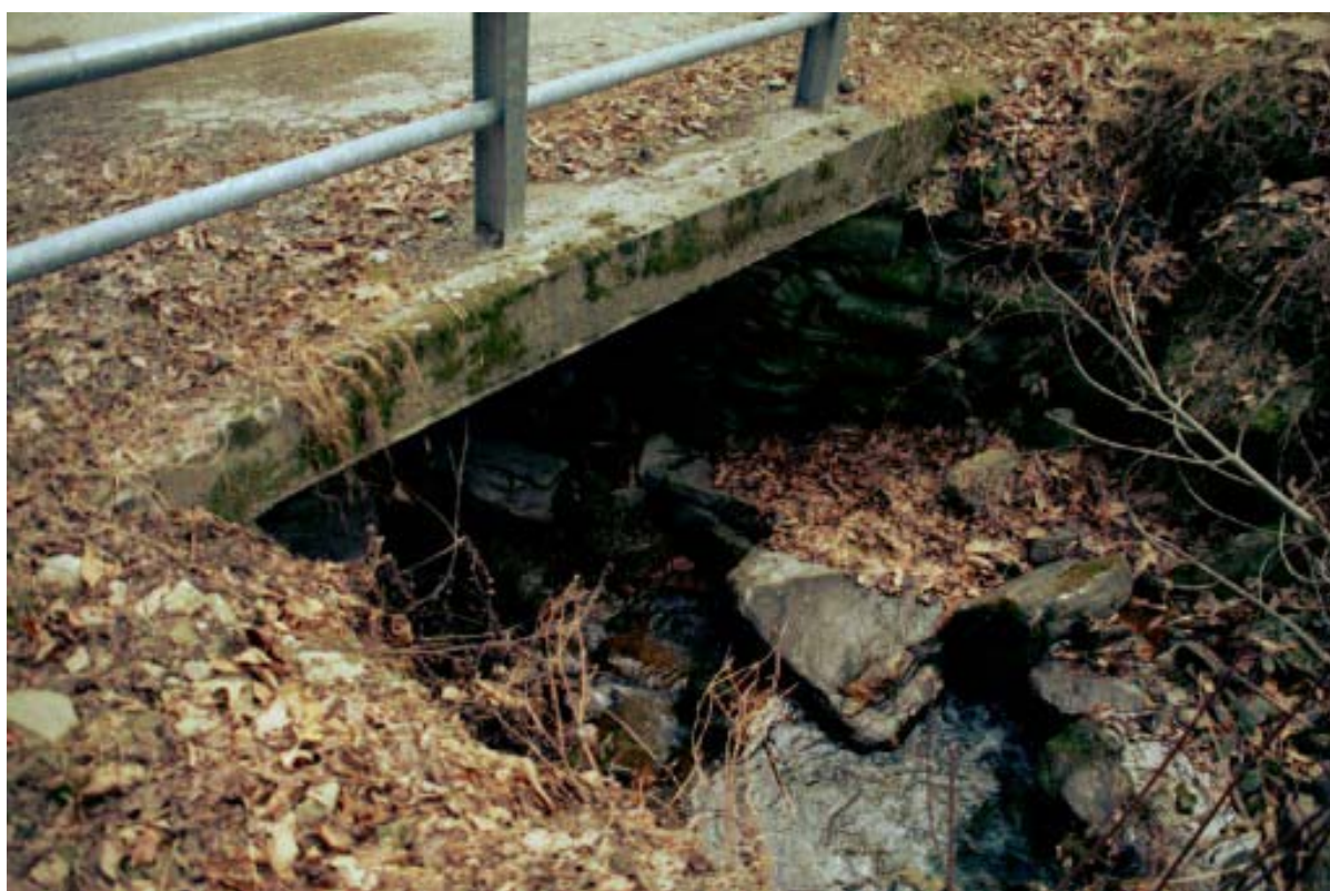
Foto 034 – Opera TREVAG034 . Ripresa da valle.
