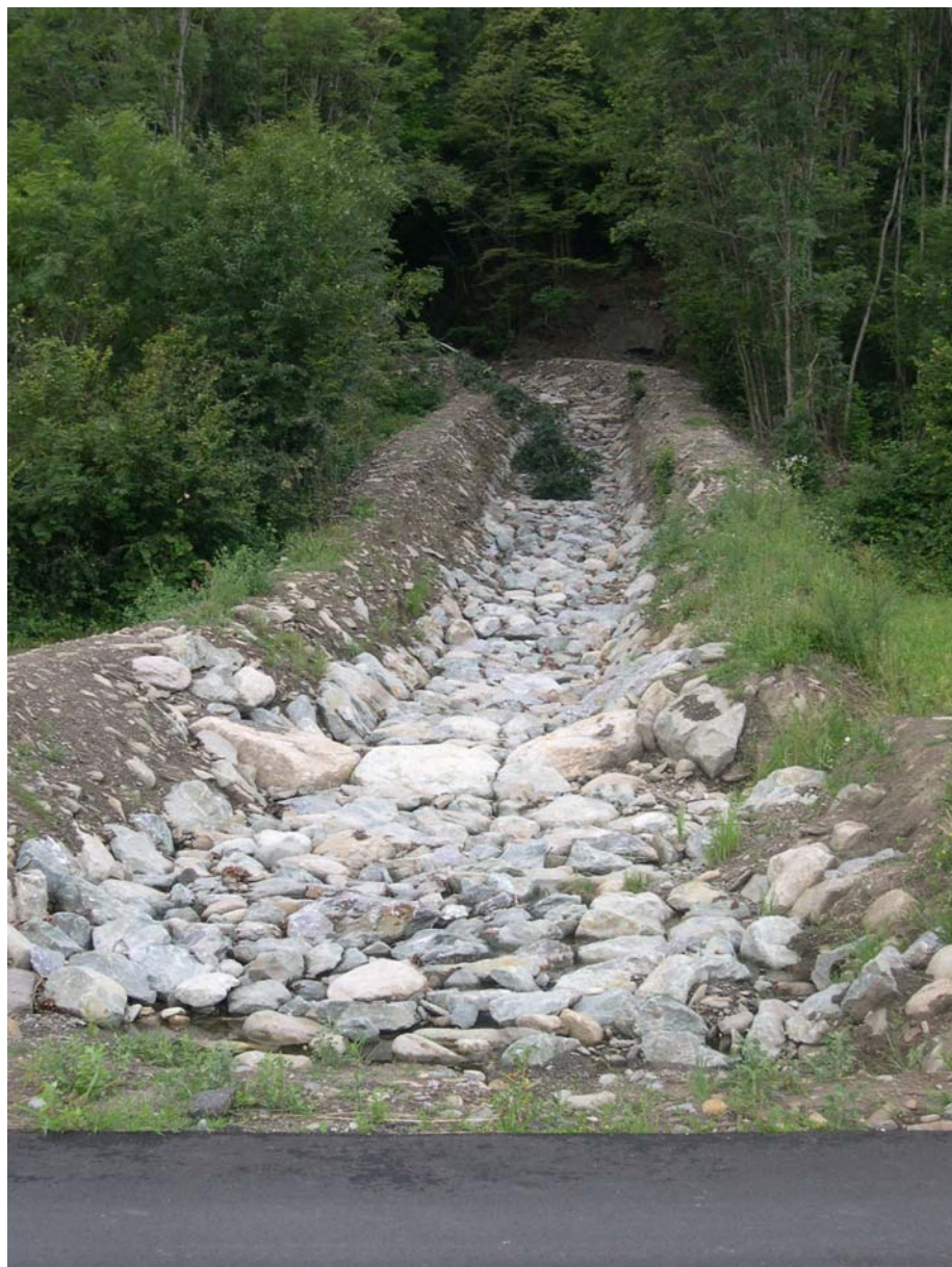
Foto 019 – Opera BATTCA019 . Ripresa da valle, dalla strada comunale.
