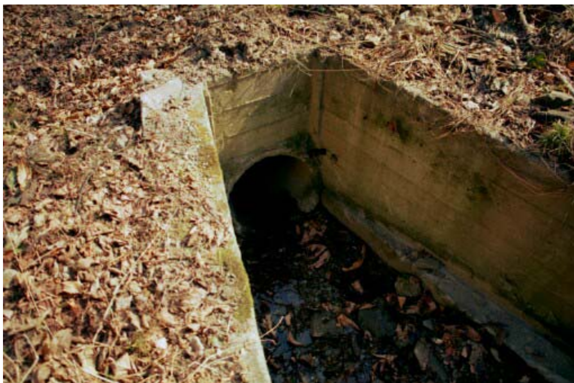
Foto 023 – Opera CANAAG023 . Ripresa da monte.
