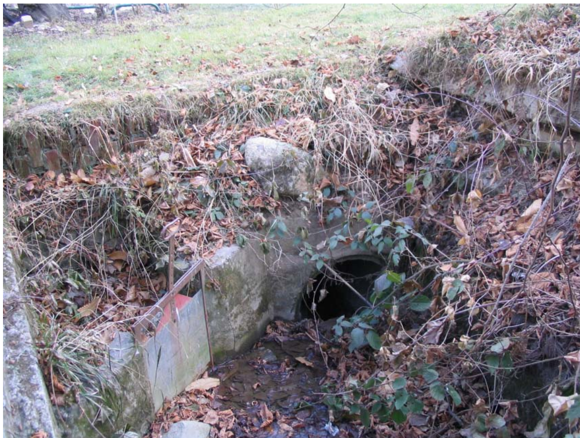
Foto 007 – Opera BATTCA007 . Ripresa dall'imbocco di monte.
