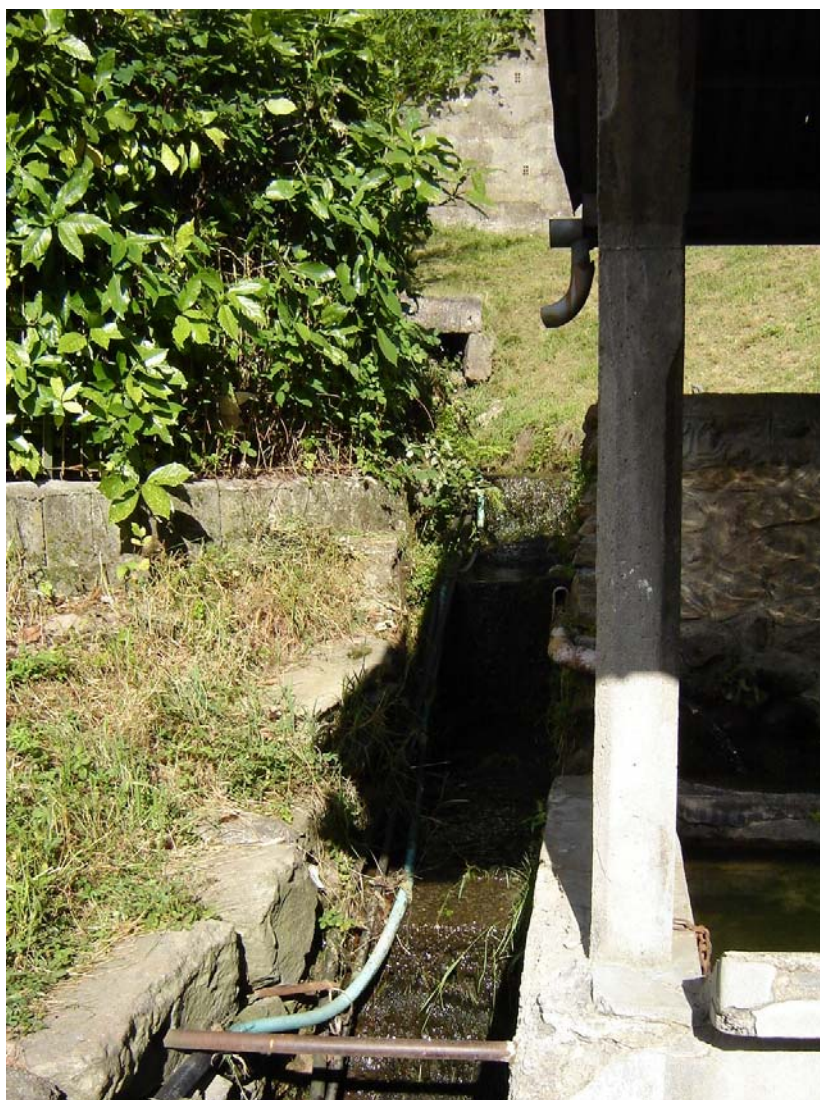
Foto 018 – Opera BATTCA018 . Ripresa da valle, dalla strada comunale.
