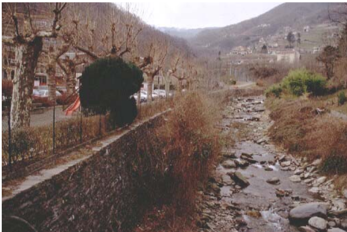
Foto 005 – Opera CANADS005 . Ripresa da valle, dal ponte CANAPO001.
