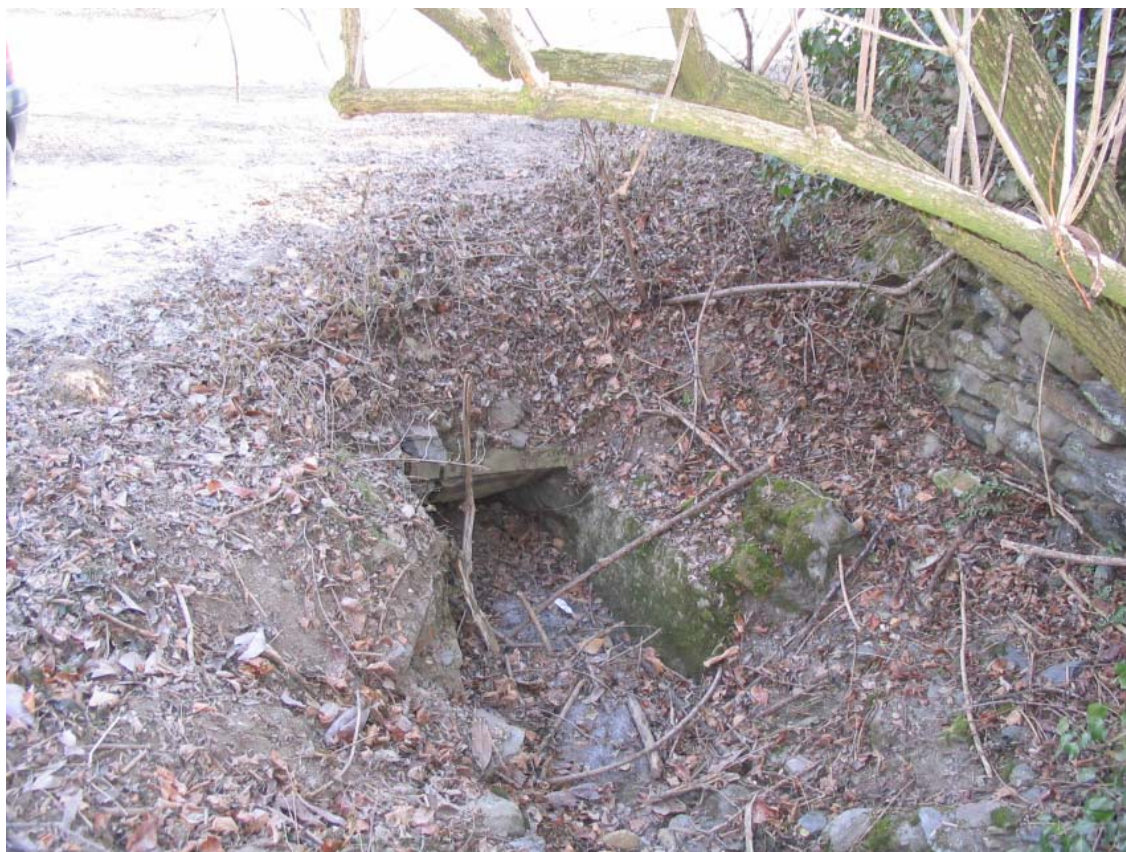
Foto 008 – Opera TREVAG008 . Ripresa da monte.
