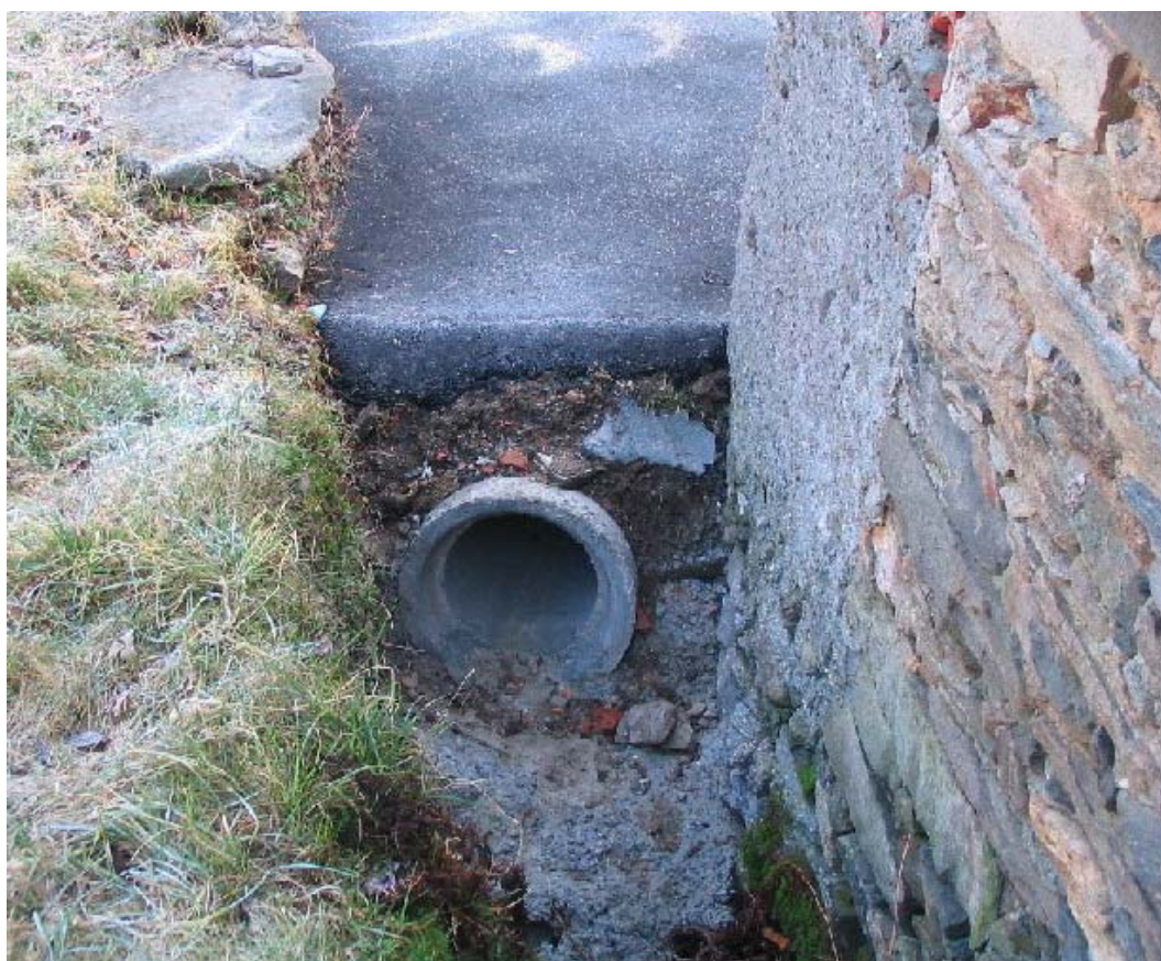
Foto 014 – Opera PENNCA014 . Ripresa da monte, sponda sinistra dell'impluvio.
