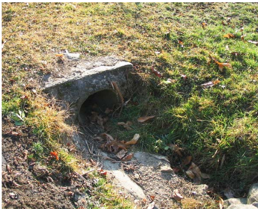
Foto 017 – Opera BATTCA017 . Ripresa da monte, sponda sinistra dell'impluvio.
