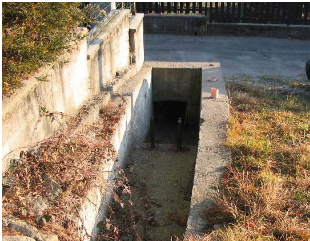
Foto 013 – Opera BATTCA013 . Ripresa frontale da monte, dall'alveo dell'impluvio.
