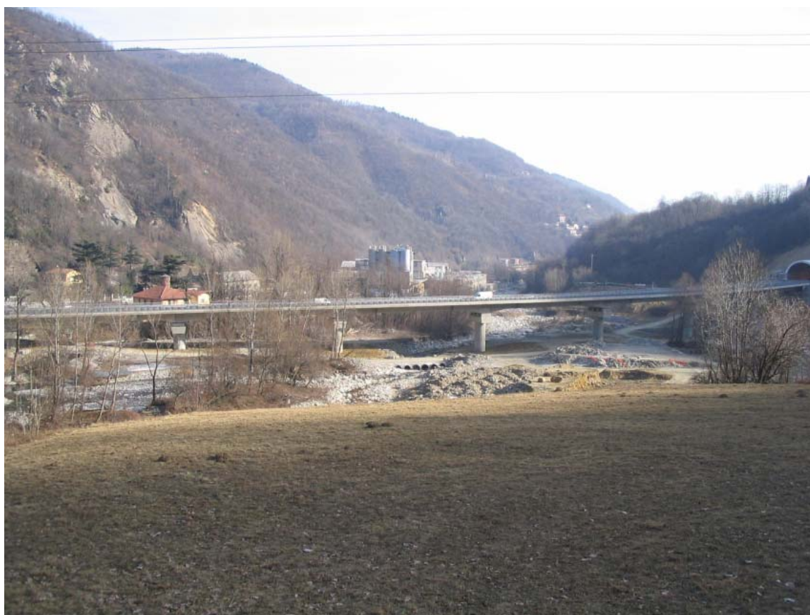
Foto 002 – Opera TREVPO002 . Ripresa laterale dalla strada di Inverso Porte.
