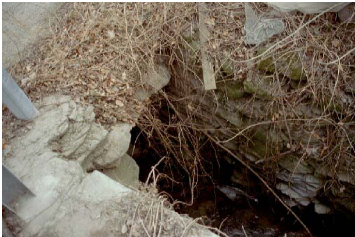
Foto 002 – Opera TREVAG002 . Ripresa da monte.
