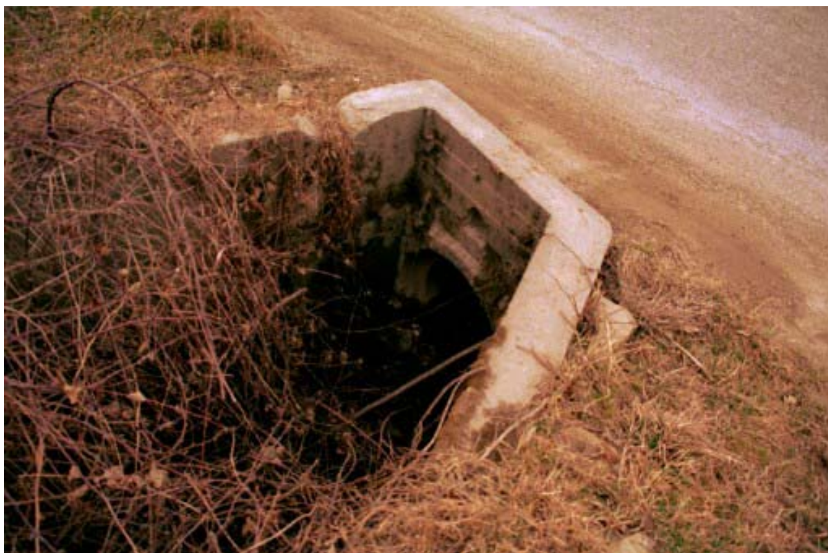
Foto 007 – Opera CANAAG007 . Ripresa da monte.
