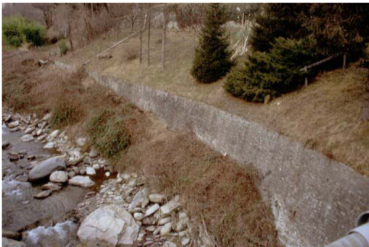
Foto 006 – Opera TREVDS006 . Ripresa da valle, dal ponte CANAPO001.
