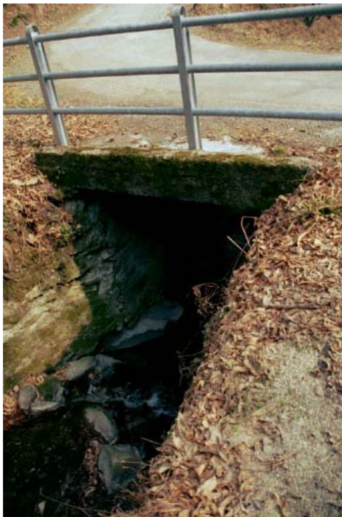
Foto 031 – Opera CANAAG031 . Ripresa da monte.
