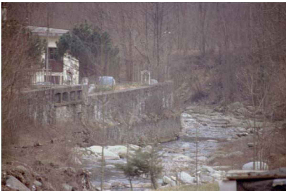
Foto 014 – Opera TREVDS014 . Ripresa da monte, sponda destra del T. Risagliardo.
