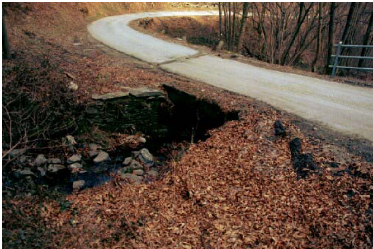
Foto 033 – Opera CANAAG033 . Ripresa da monte.
