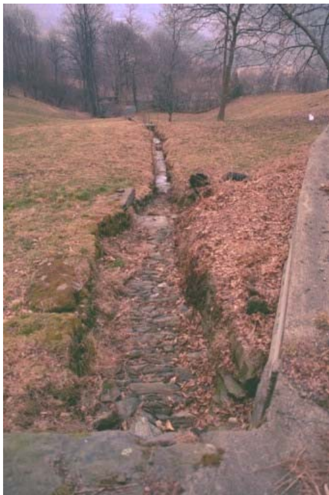
Foto 003 – Opera CANACA003 . Ripresa da monte, dall'attraversamento TREVAG014.
