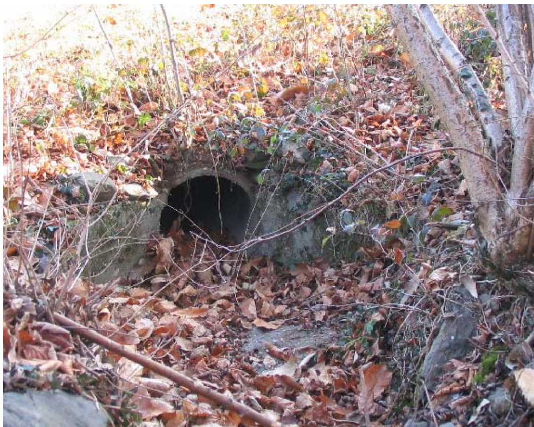
Foto 016 – Opera PENNCA016 . Ripresa frontale da monte, dall'alveo dell'impluvio.
