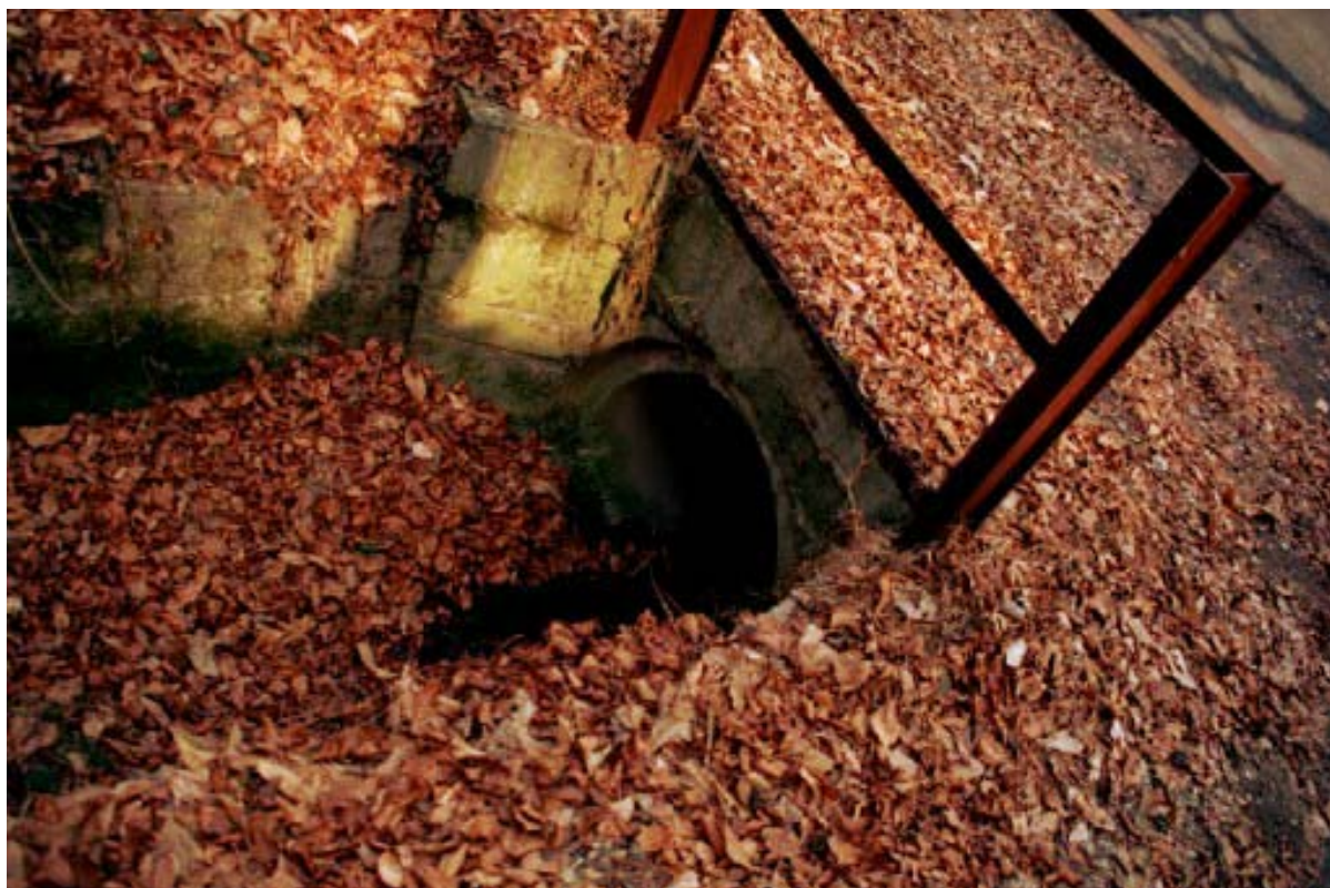
Foto 035 – Opera CANAAG035 . Ripresa da monte.
