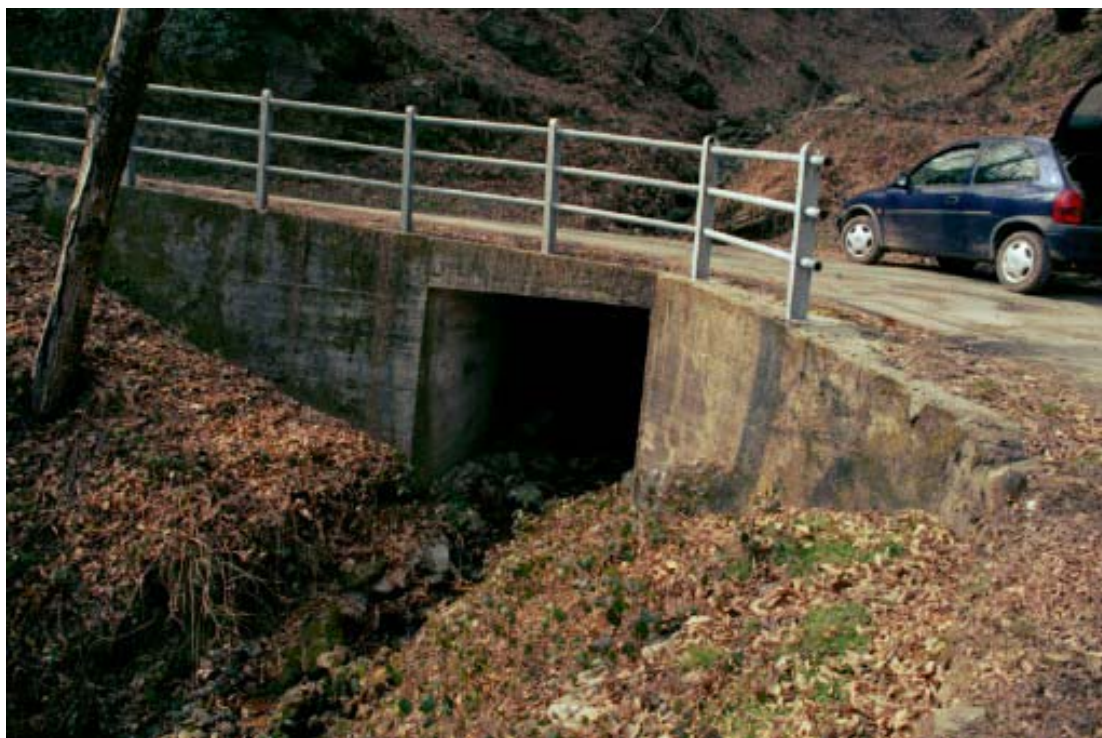
Foto 032 – Opera TREVAG032 . Ripresa da valle.
