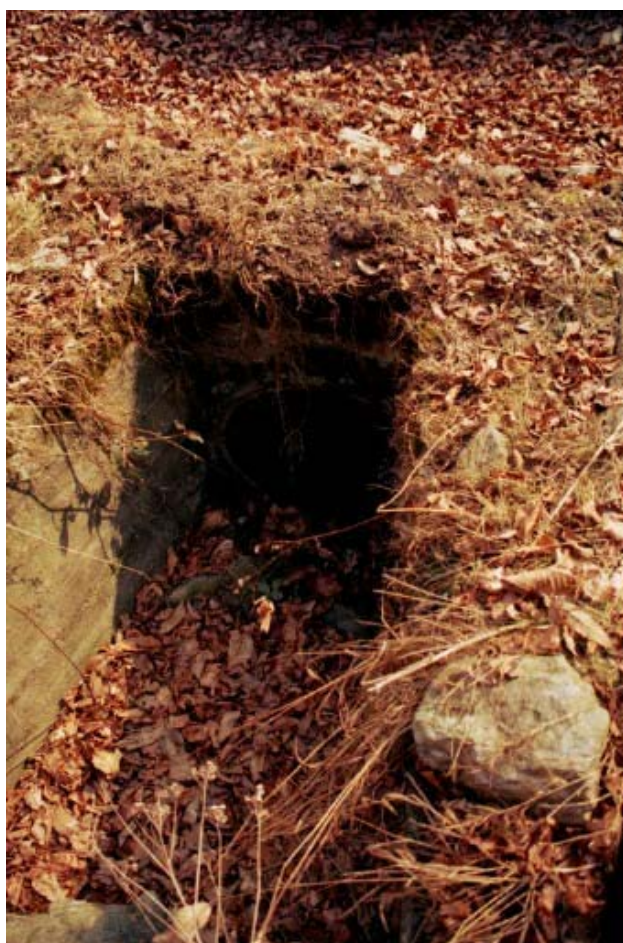
Foto 024 – Opera TREVAG024 . Ripresa da monte.
