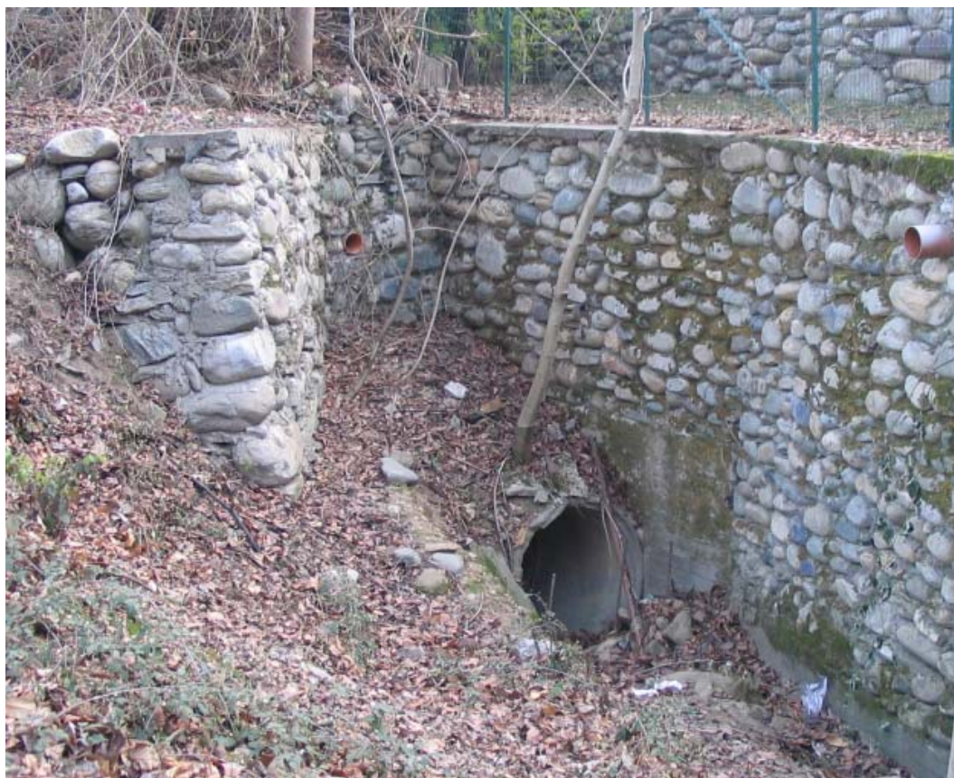
Foto 008 – Opera PENNCA008 . Ripresa dall'imbocco di monte.
