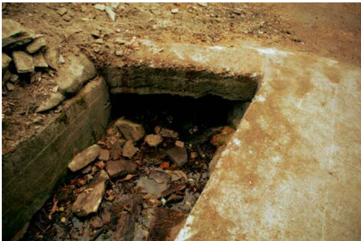
Foto 012 – Opera TREVAG012 . Ripresa da monte.
