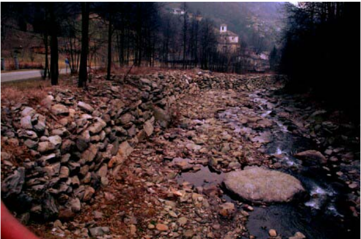
Foto 004 – Opera TREVDS004 . Ripresa dal ponte TREVPO004.
