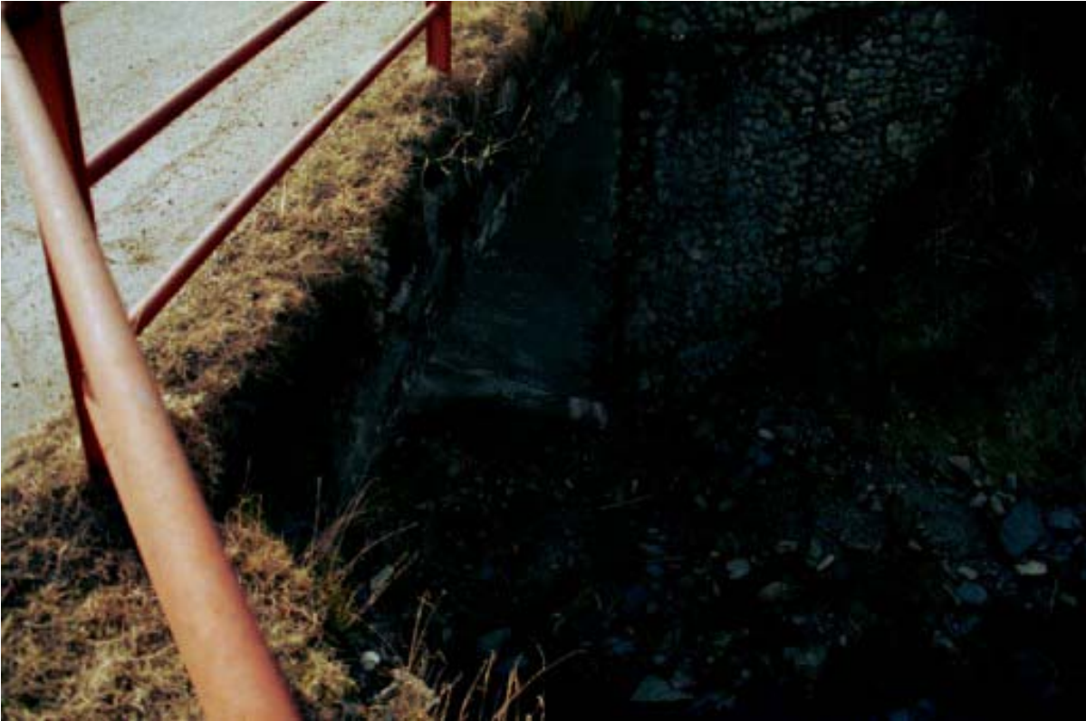
Foto 009 – Opera CANAPO009 . Ripresa da monte.
