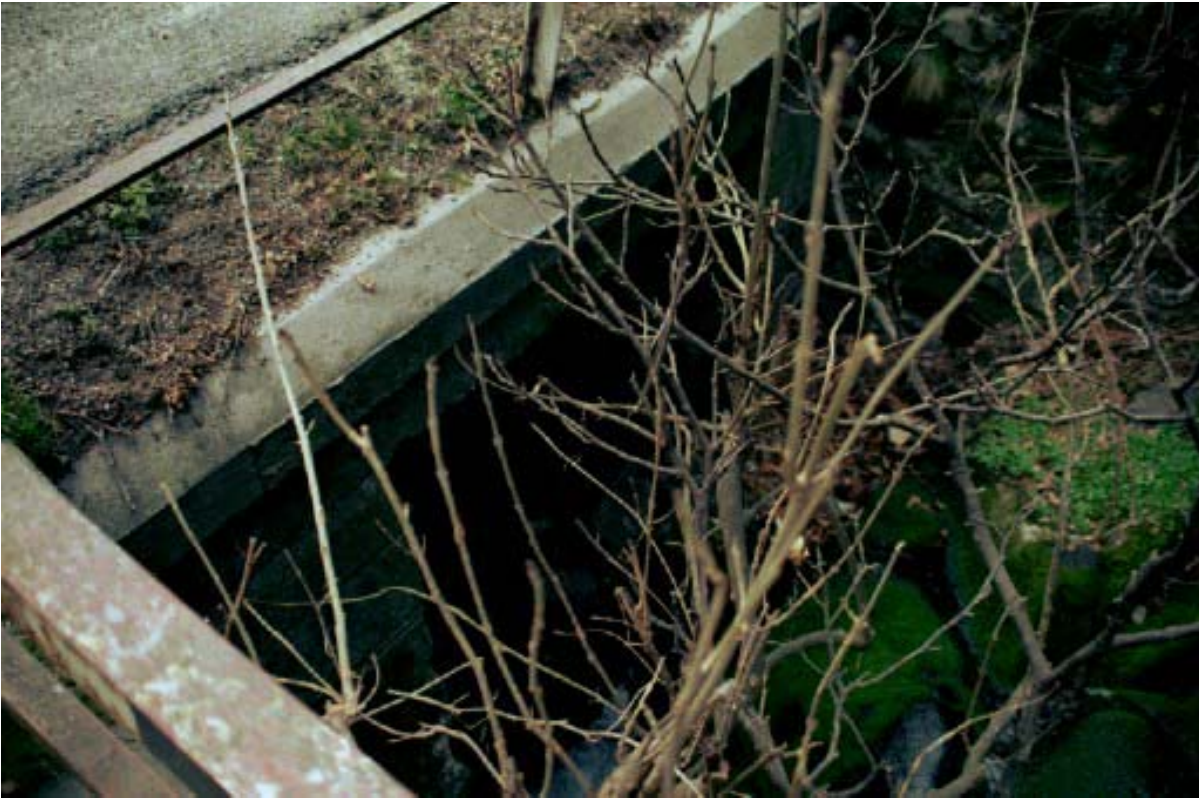
Foto 007 – Opera CANAAG007 . Ripresa da monte.
