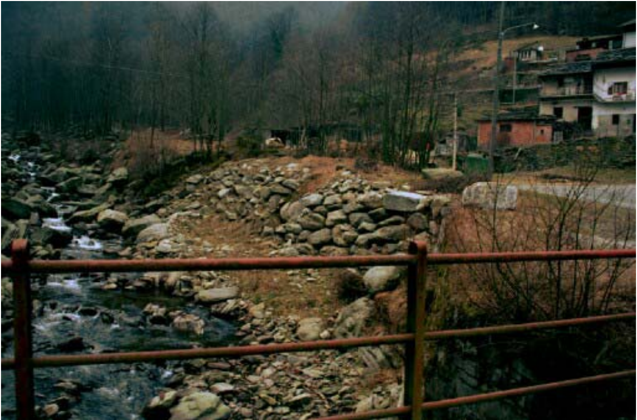
Foto 005 – Opera CANADS005 . Ripresa dal ponte TREVPO004.
