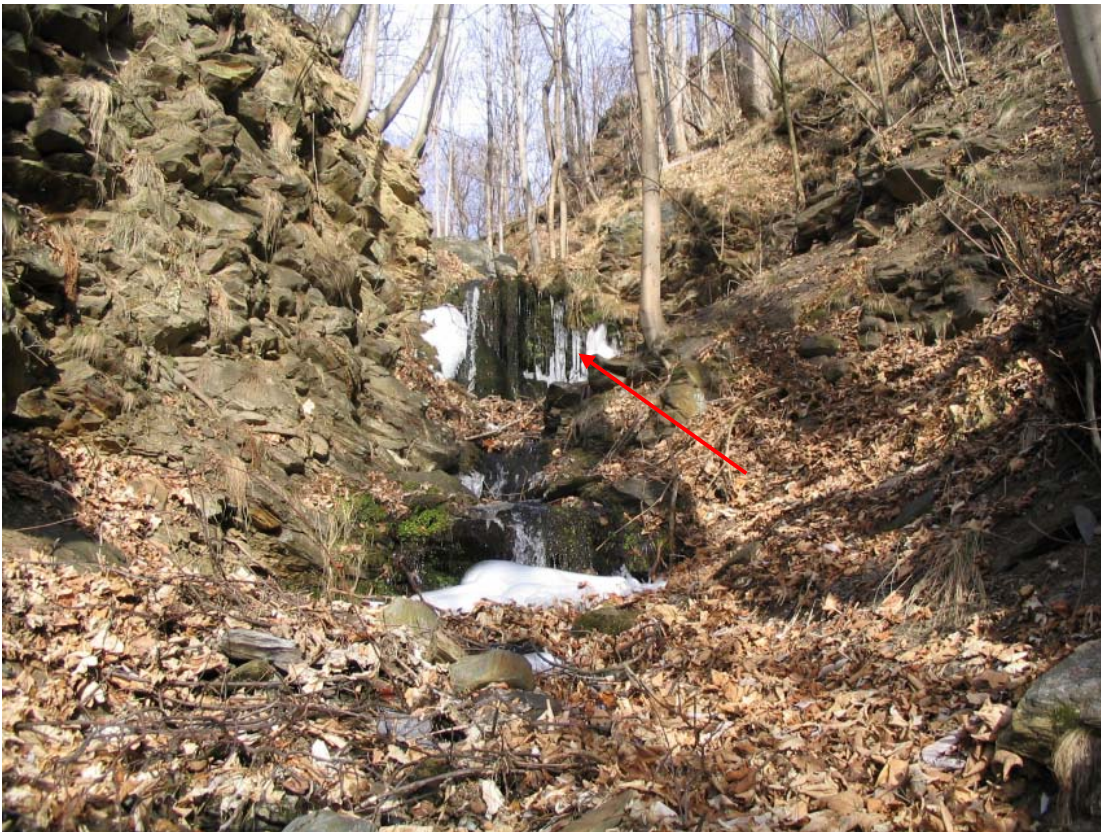
Foto 004 – Opera TREVBR004 . Ripresa da valle.
