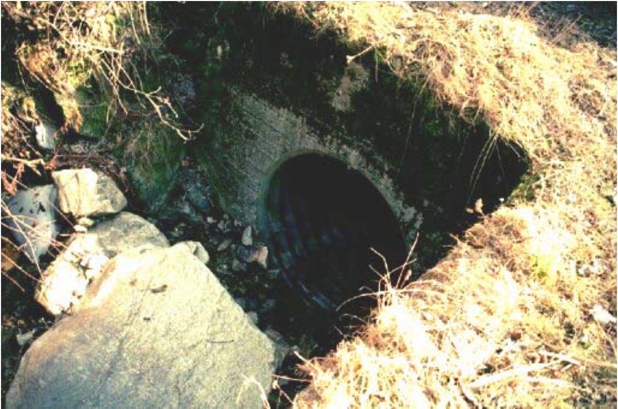
Foto 015 – Opera CANAAG015 . Ripresa da monte.
