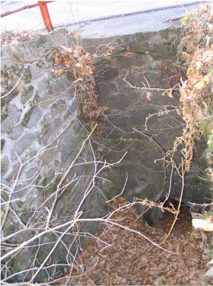
Foto 009 – Opera CANAAG009 . Ripresa da monte.
