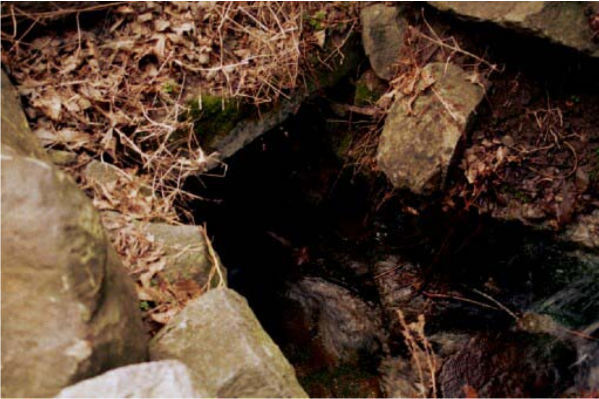
Foto 005 – Opera CANAAG005 . Ripresa da monte.
