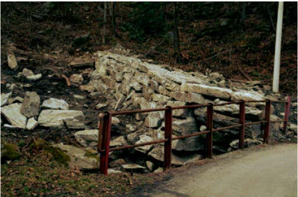
Foto 006 – Opera TREVDS006 . Ripresa dal ponte TREVPO006.
