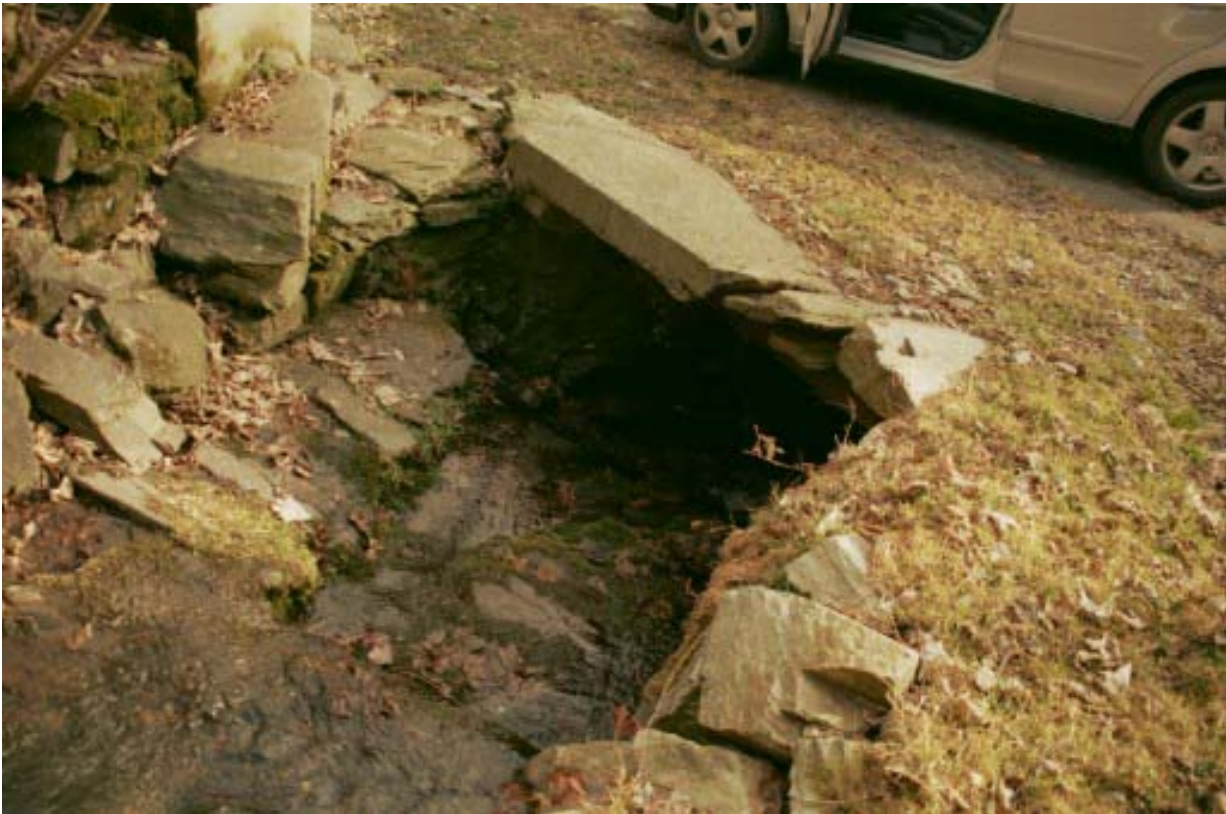
Foto 019 – Opera CANAAG019 . Ripresa da monte.
