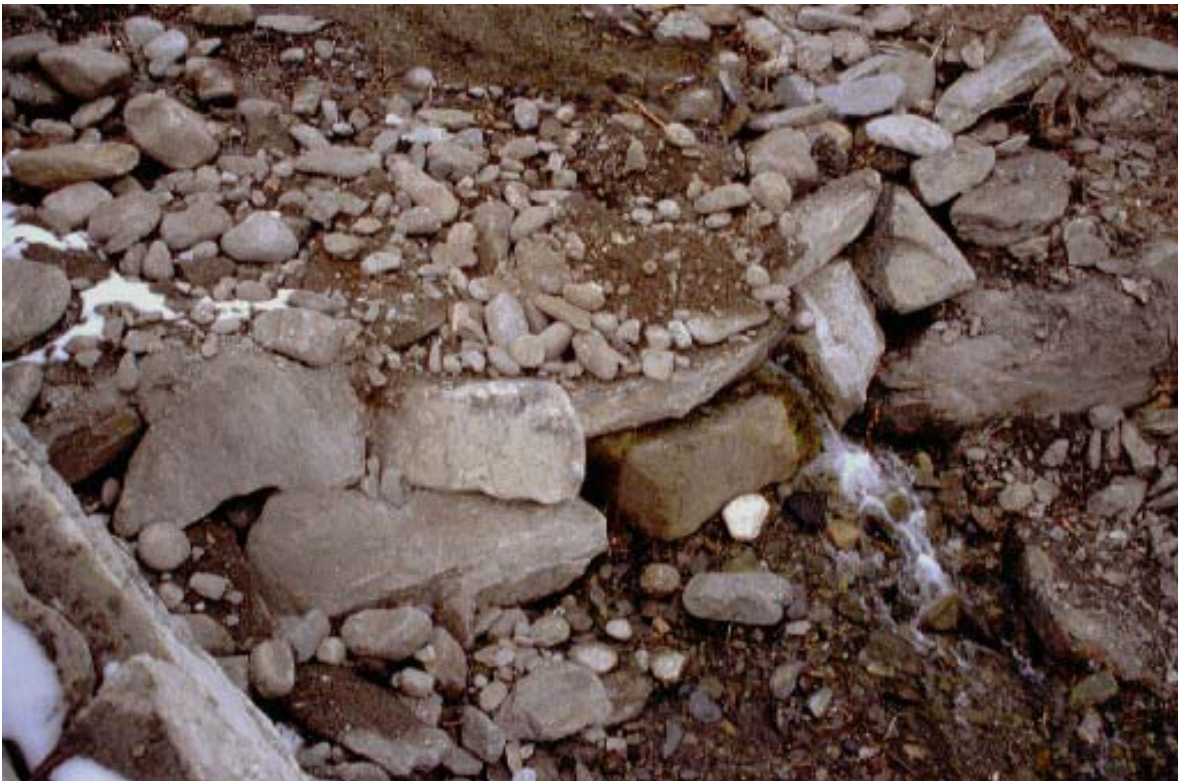
Foto 002 – Opera TREVSO002 . Ripresa da valle.
