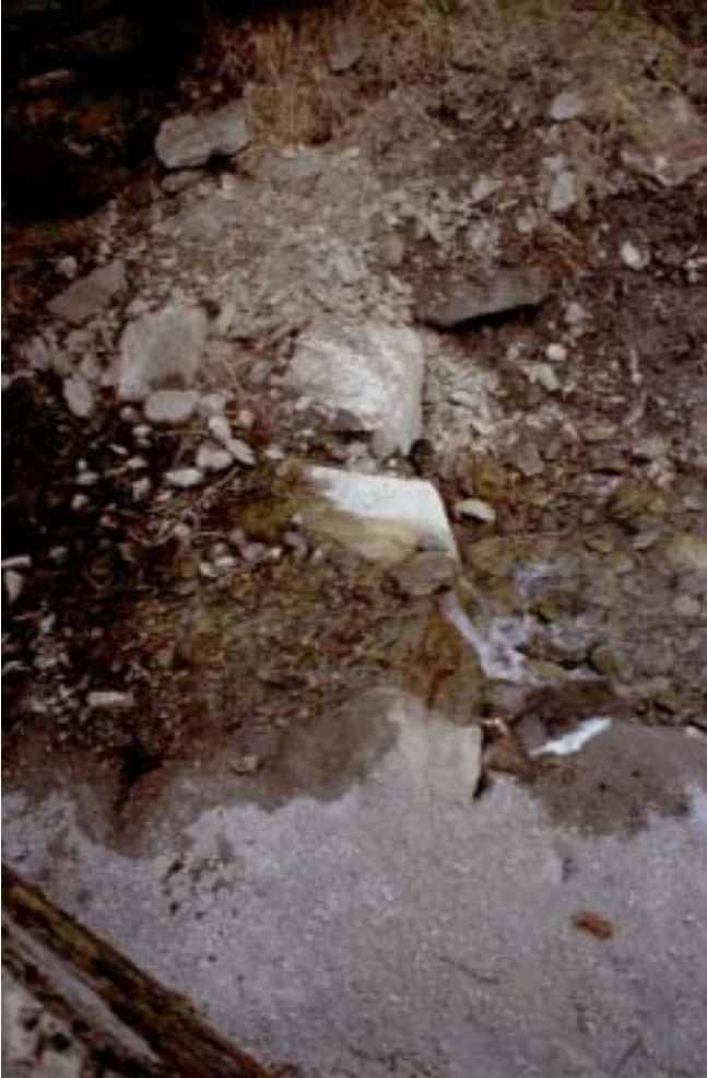
Foto 003 – Opera CANASO003 . Ripresa da sponda destra del rio.
