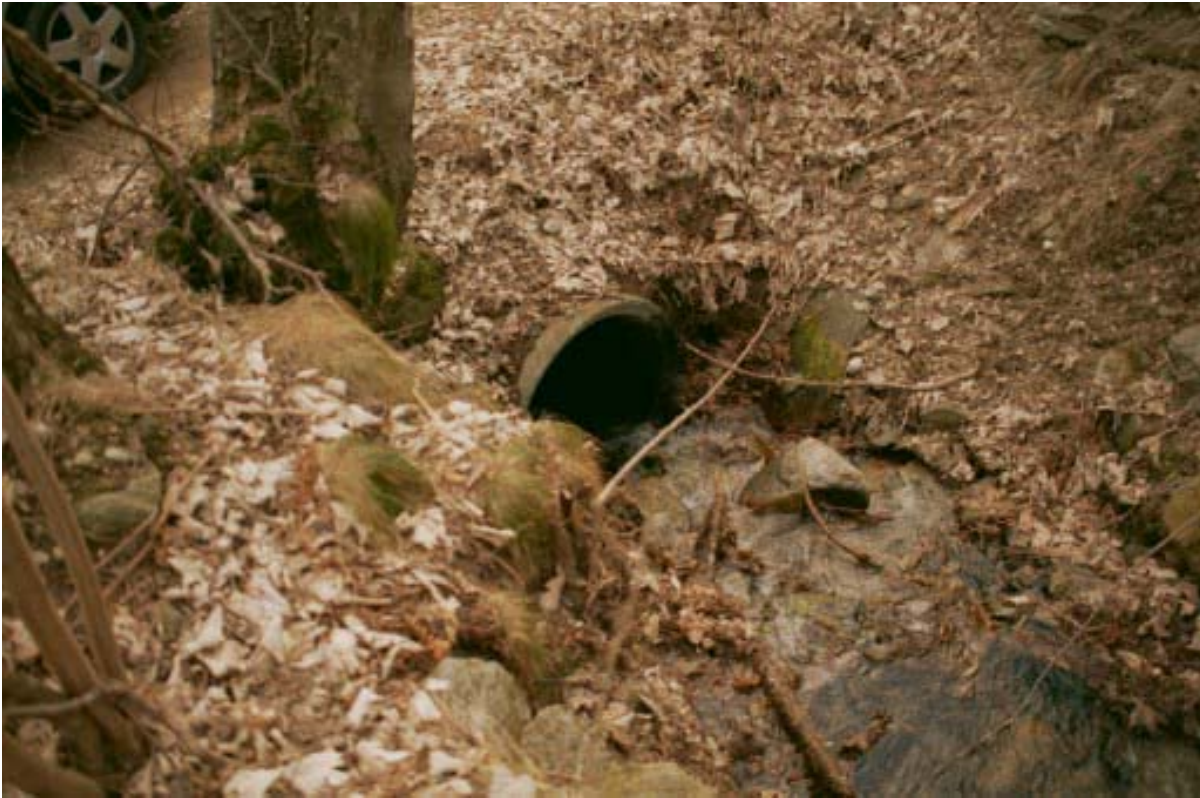
Foto 021 – Opera CANAAG021 . Ripresa da monte.
